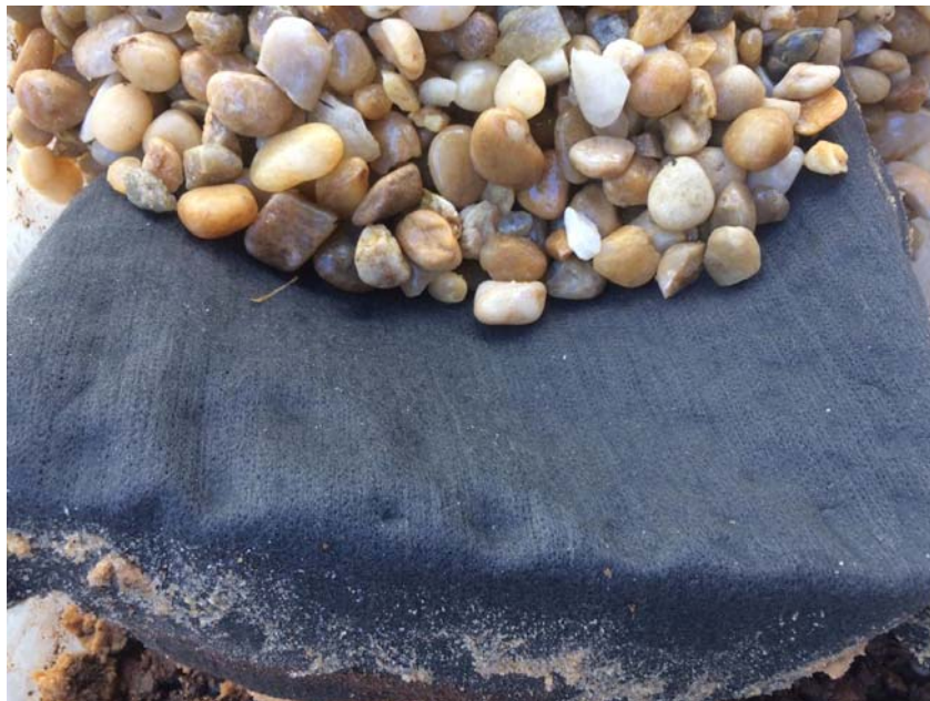
Figura 23 – Face do geotêxtil em contato com o seixo.
