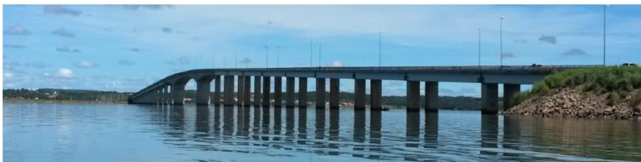
Figura 8 - Ponte Fernando Henrique Cardoso
