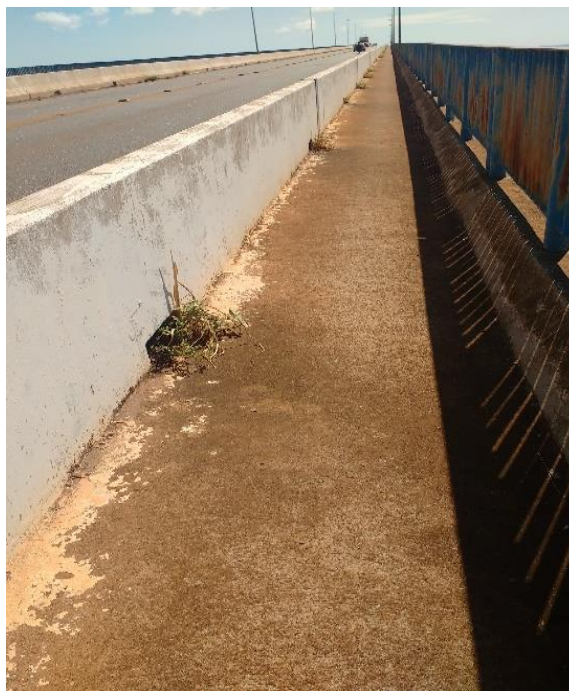
Figura 13 – Desgaste superficial do passeio lateral.
