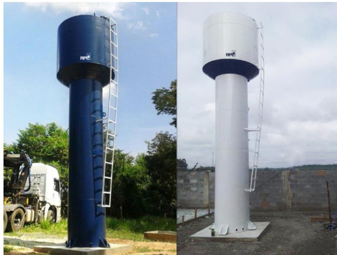
Figura 16: Reservatório metálico elevado.
