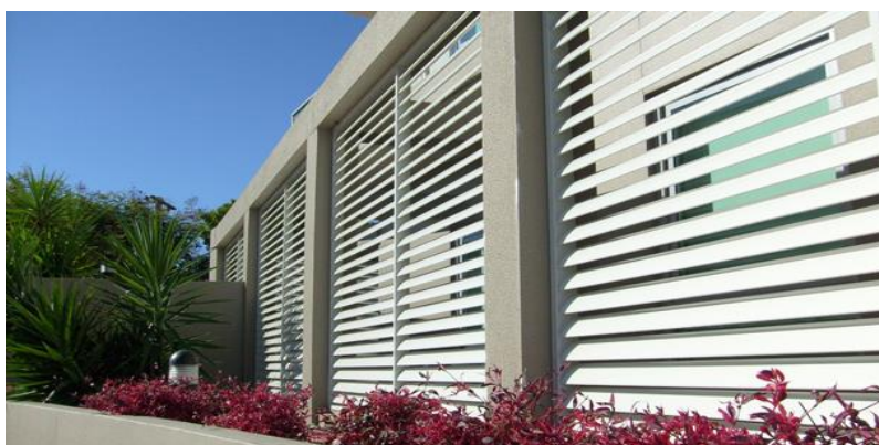
Figura 7: Brises aplicados em fachadas
