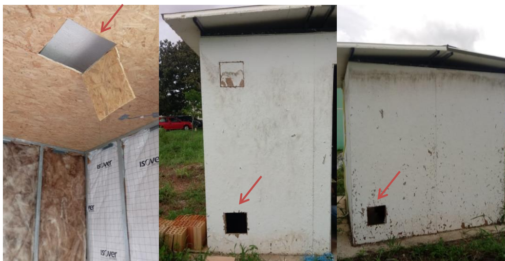
Figura 15: Célula C1 com vãos para ventilação interna.
