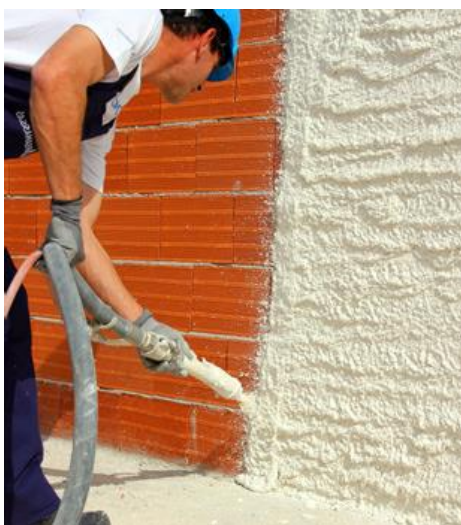
Figura 4: Reboco com argamassa térmica
