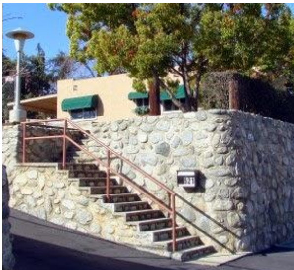
Figura 16 - Muro de concreto ciclópico
