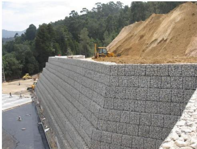
Figura 13 - Gabião tipo caixa
