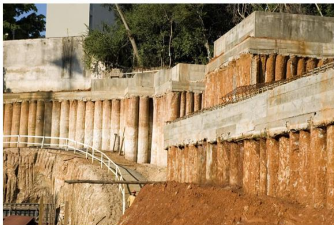
Figura 9 - Parede de estacas justapostas
