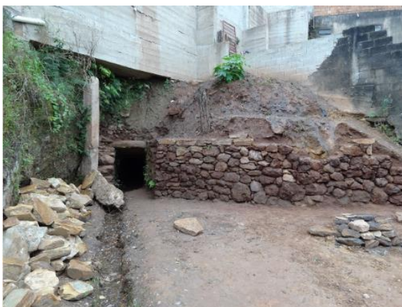
Figura 11 - Muro de pedra
