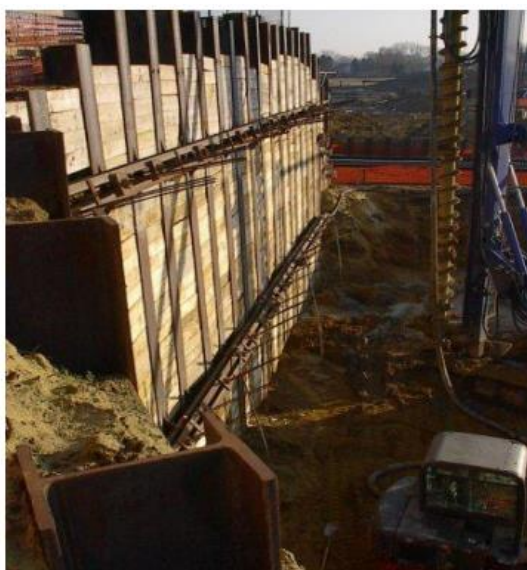
Figura 7 - Cortina Tipo Berlim multiancorada
