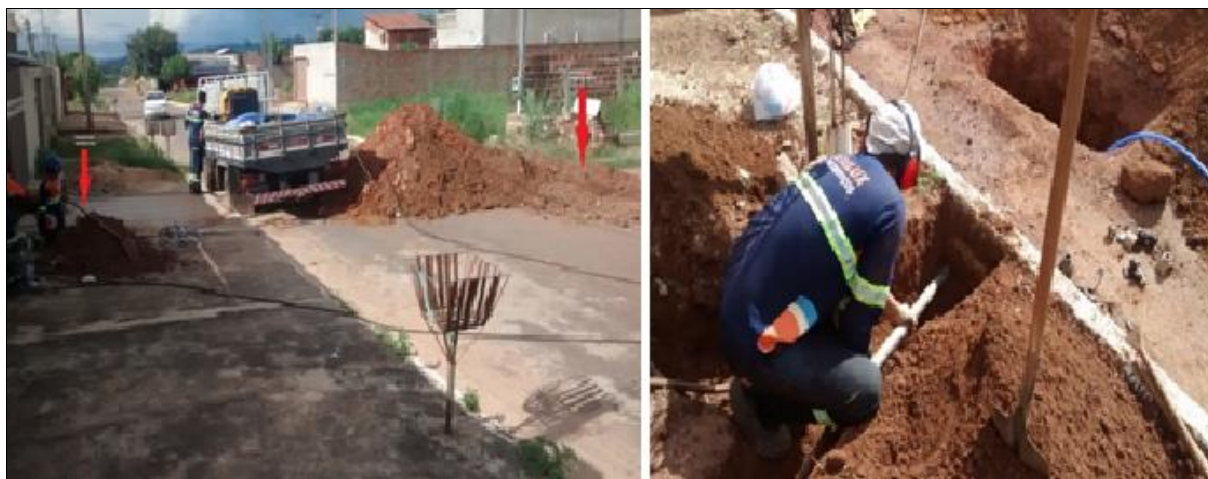
Figura 16 - Execução de ramal de ligação pelo método não destrutivo. Fonte: Adaptado de Parente e Silva (2016).
