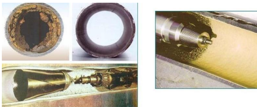
Figura 3 - Método Spray lining. Fonte: ABRATT, 2007.
