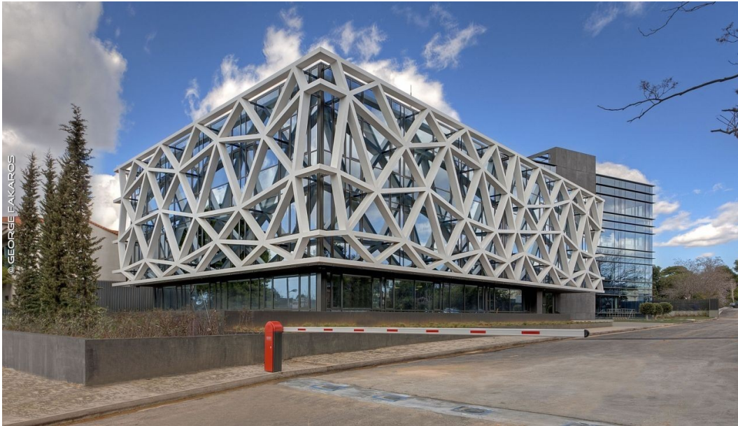
Figura 39: Complexo de escritórios EIGHT.
