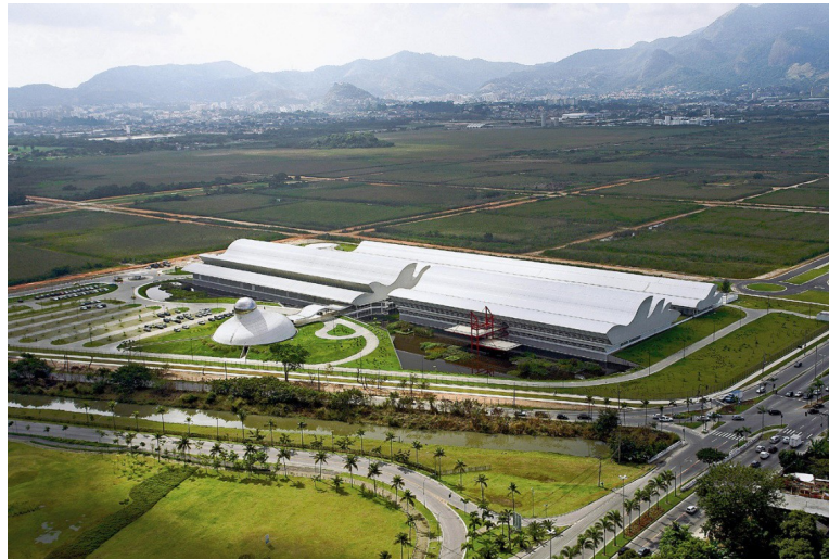
Figura 06: Vista aérea do Hospital Rede Sarah.
