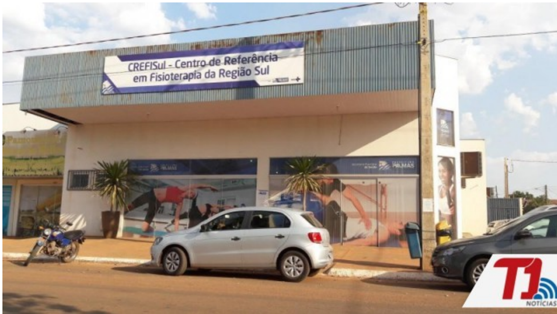
Figura 04: Entrada principal do Centro.
