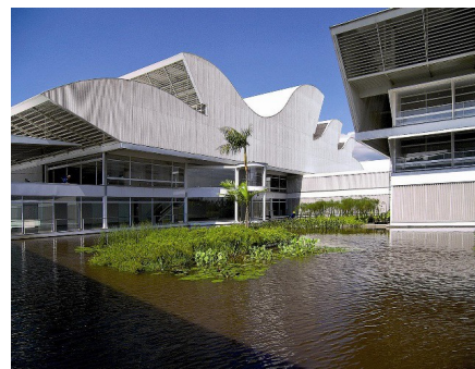
Figura 07: Sistema de aletas móveis implantadas na cobertura do Hospital Rede Sarah.
