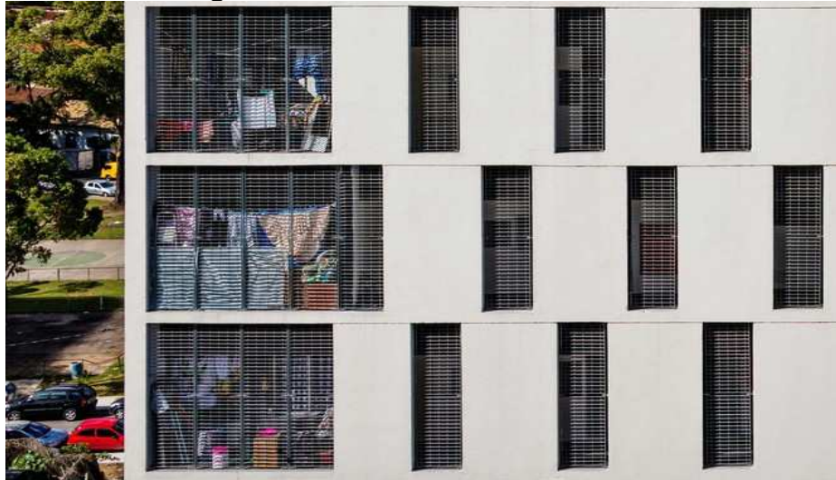
Figura 16: Janelas de Grade.
