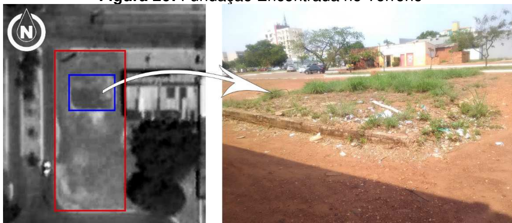
Figura 26: Fundação Encontrada no Terreno
