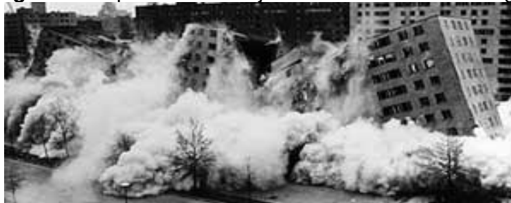
Figura 2: Implosão do Conjunto Habitacional Pruitt-Igoe
