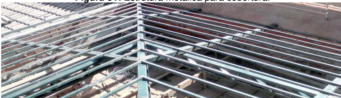
Figura 51: Estrutura metálica para cobertura.
