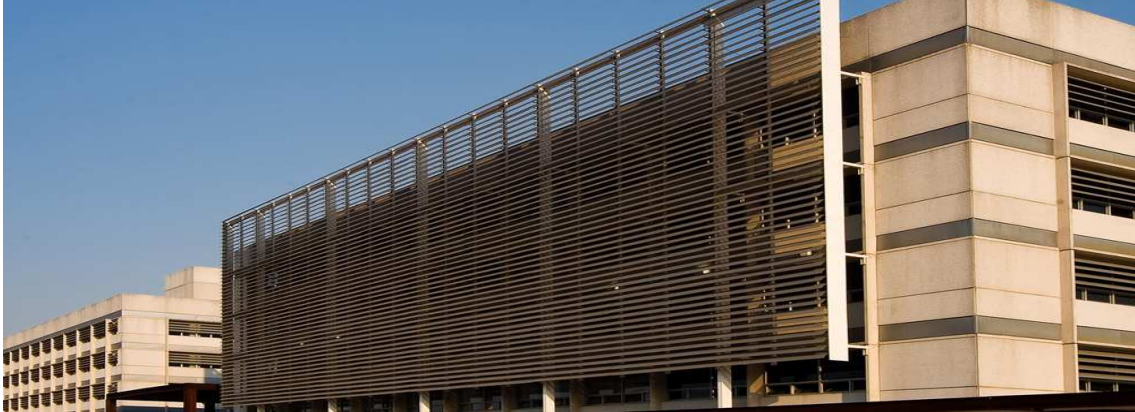
Figura 54: Bises em fachada
