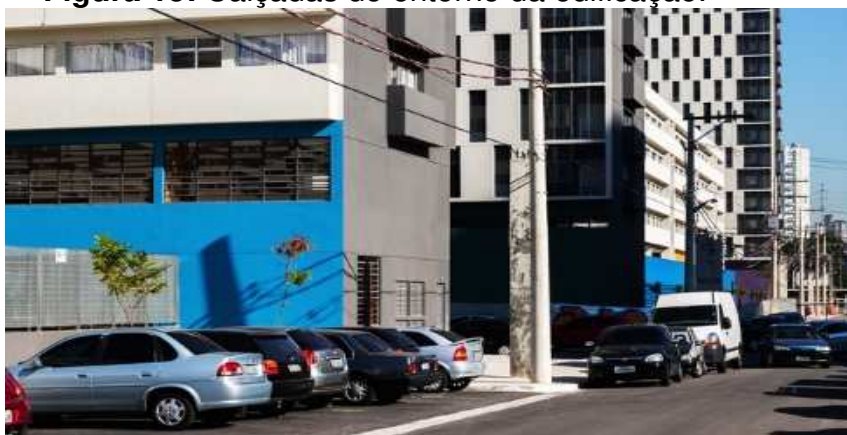
Figura 15: Calçadas do entorno da edificação.
