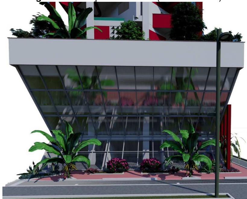
Figura 5: Vidraças inclinadas (fachada norte).
