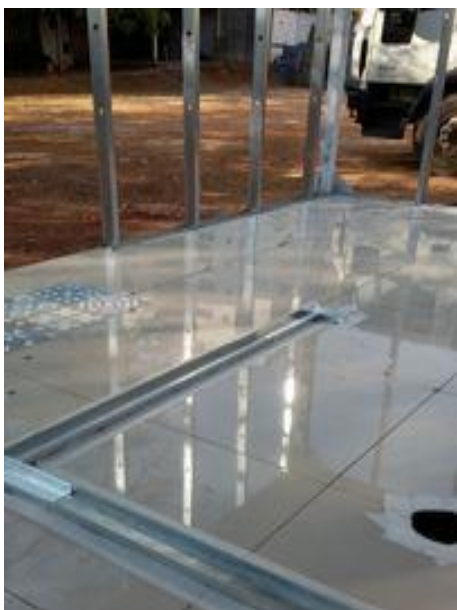
Figura 32 - Detalhes construtivos do Sistema Modular: piso (a), e paredes com instalação elétrica e hidráulica (b)
