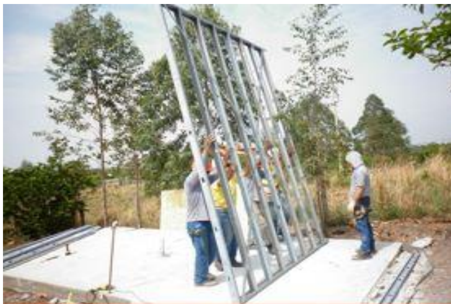
Figura 31 - Parede estrutural LSF em fase de construção
