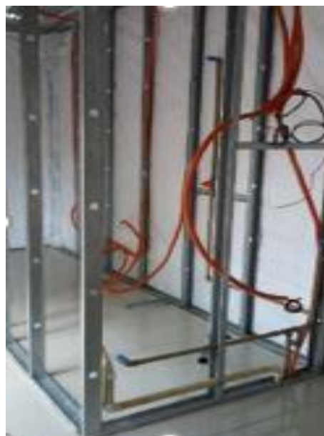
Figura 32 - Detalhes construtivos do Sistema Modular: piso (a), e paredes com instalação elétrica e hidráulica (b)
