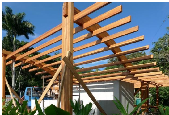
Figura 48: Madeira laminada colada
