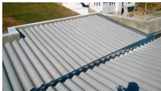
Figura 47: Aplicação telha termoacústica
