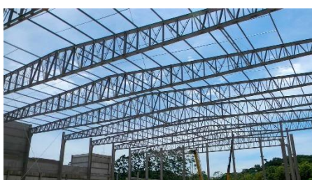
Figura 33: Treliça Metálica e Telha Termoacústica.
