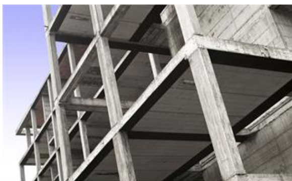
Figura 31: Estrutura em Concreto Armado.
