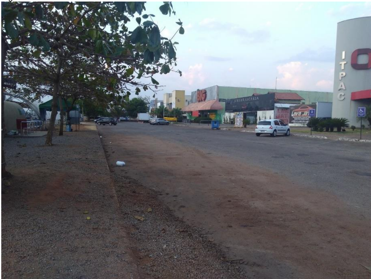
Figura 10: Estacionamento com asfalto
