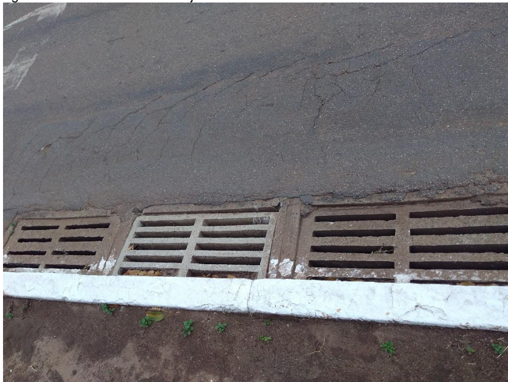
Figura 35: Boca de Lobo de Sarjeta
