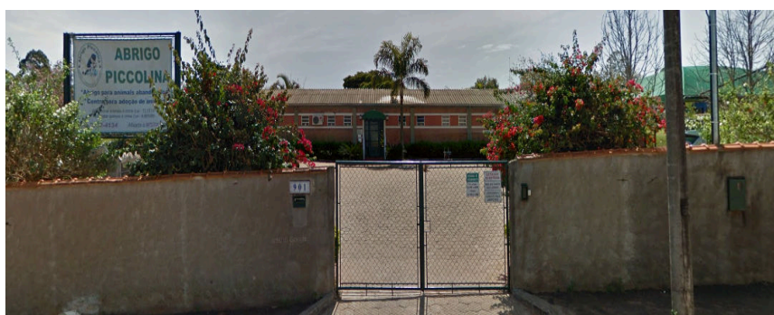
Figura 13 - Abrigo Piccolina, Fachada
