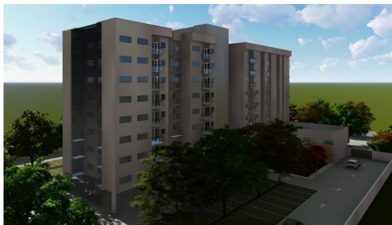
Figura 20: Brise Horizontal, fachada oeste.
