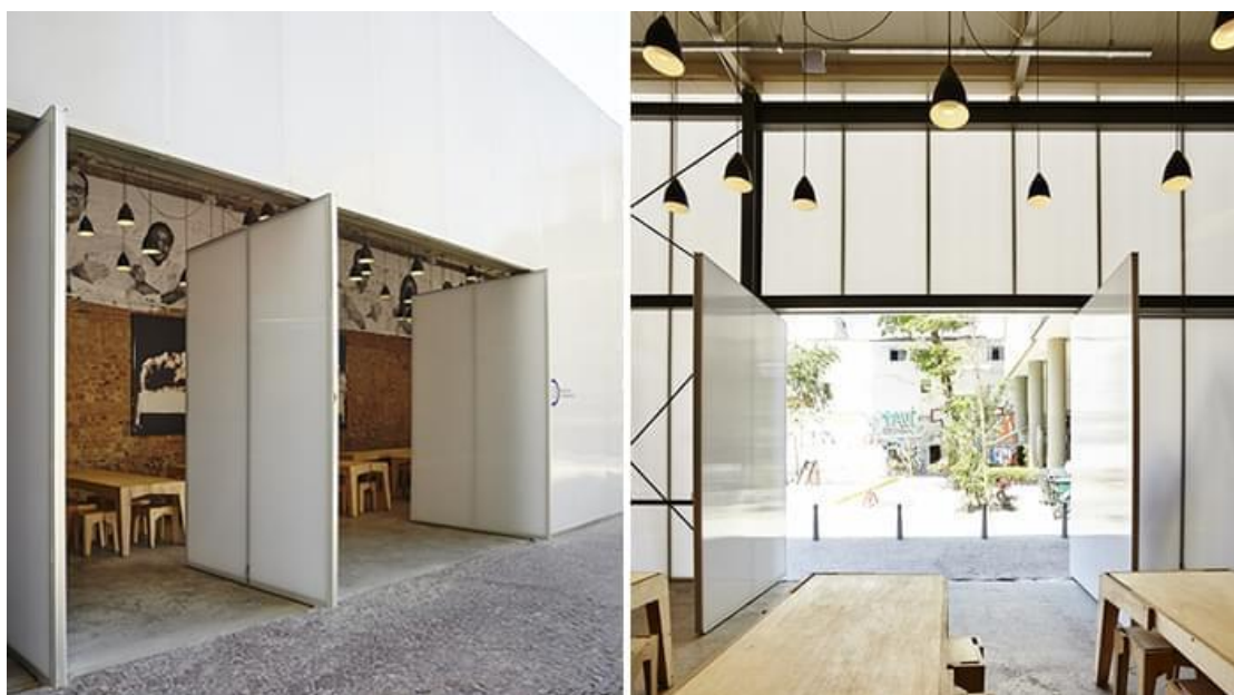
Figura 19 – Chapas de policarbonato na entrada do Refettorio Gastromotiva
