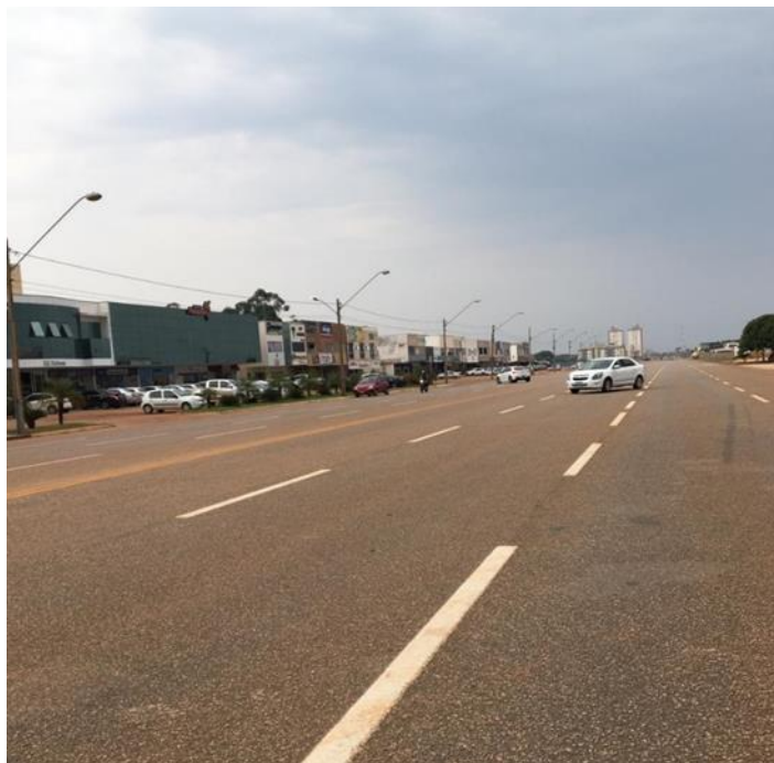
Figura 46: Imprudência do condutor do veículo ao fazer retorno indevido
