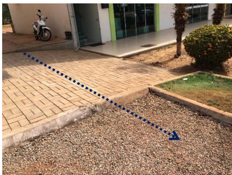
Figura 59: Demonstração da ampliação da calçada
