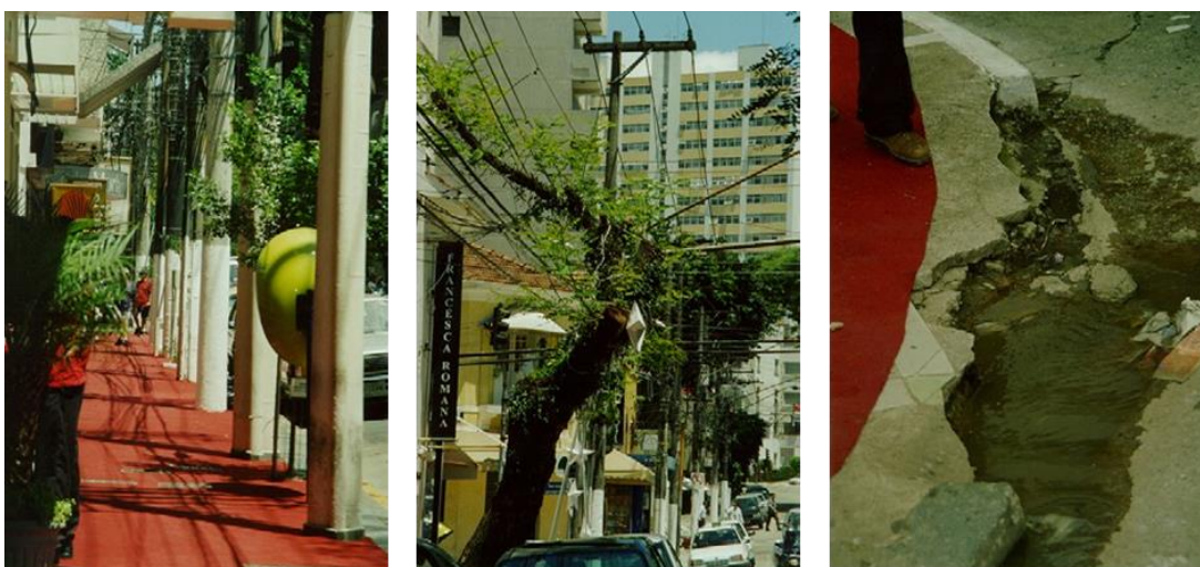
Figura 12: Problemas quanto a passagem livre dos pedestres; Poluição visual dos cabos elétricos; Falta de acessibilidade
