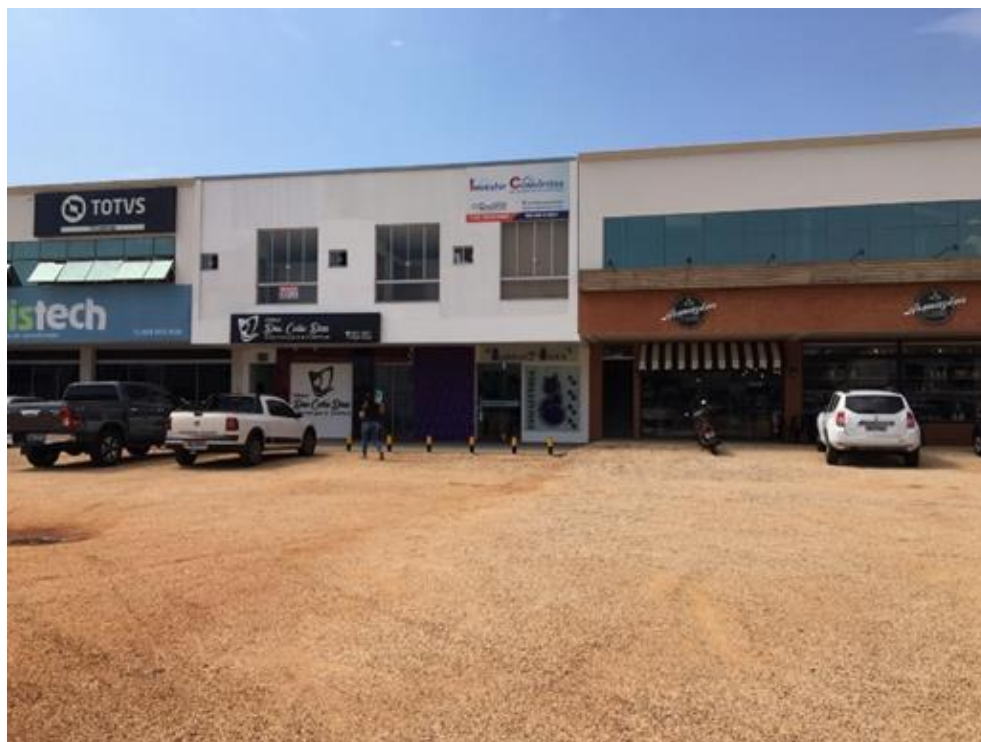
Figura 35: Tipologias dos edifícios na Avenida LO-09
