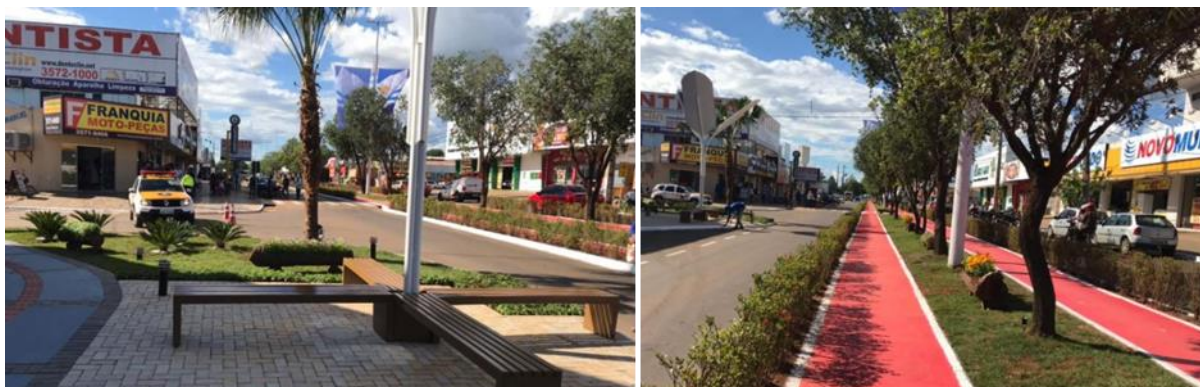
Figura 32: Imagens de conclusão da primeira etapa: Calçada e Canteiro Central
