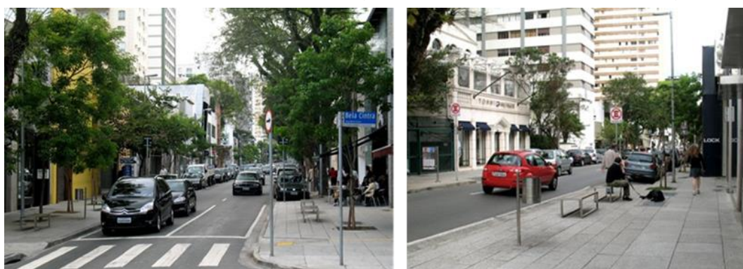
Figura 17: Vistas da rua e da calçada após melhorias da requalificação
