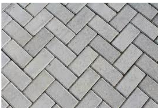
Figura 11 – Paginação do piso intertravado
