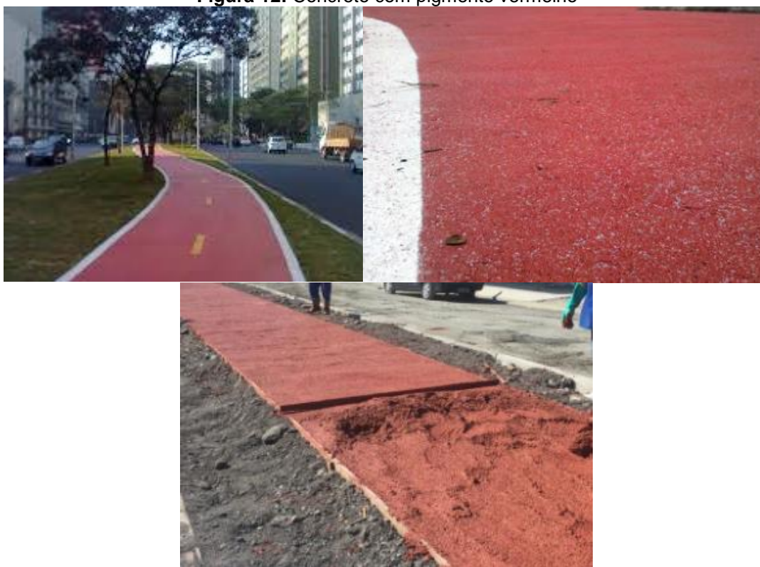
Figura 12: Concreto com pigmento vermelho
