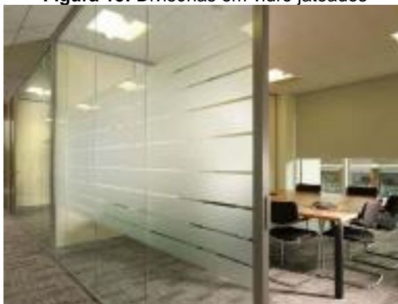
Figura 15: Divisórias em vidro jateados
