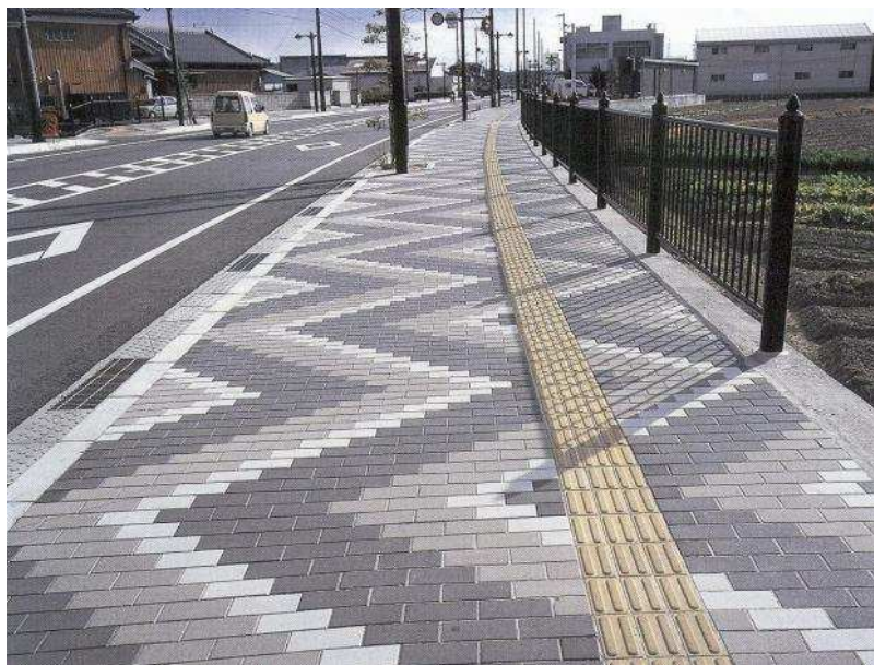
Fig. 04 – Calçada nivelada com piso tátil direcional e intertravado
