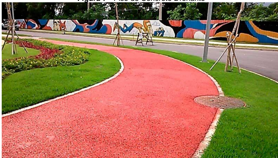
Figura 7 - Piso de Concreto Drenante
