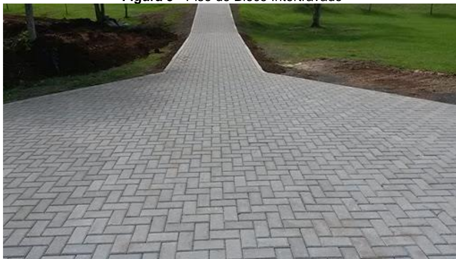
Figura 5 - Piso de Bloco Intertravado
