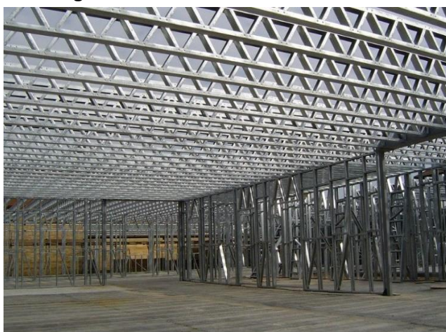
Figura 50: Pavilhão em steel frame
