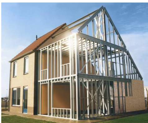
Figura 27: Estrutura em Steel frame
