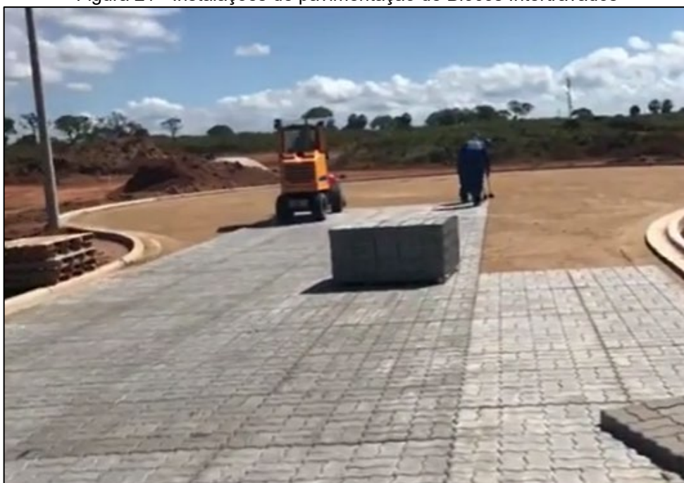
Figura 21 - Instalações de pavimentação de Blocos Intertravados
