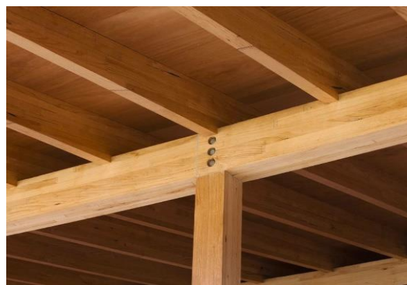
Figura 7 - Estrutura em madeira
