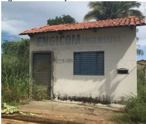
Figura 20: Edificação existente terreno
