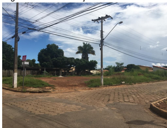
Figura 21: Pavimentação asfáltica e intertravada
