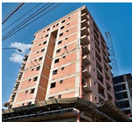
Figura 26. Fechamento externo em alvenaria
