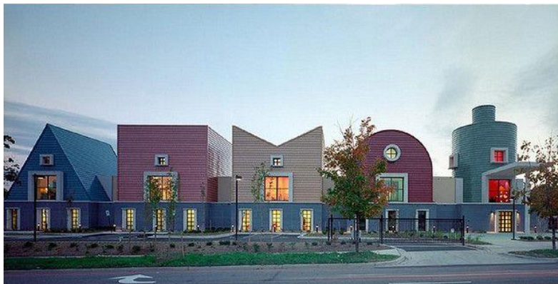
Figura 1. Fachada da St. Coletta of Greater
