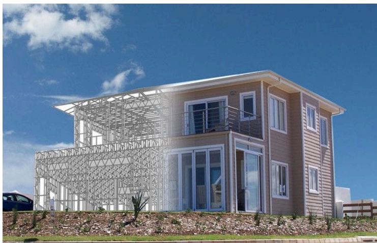
Figura 35: Exemplo de obra com Steel Frame
