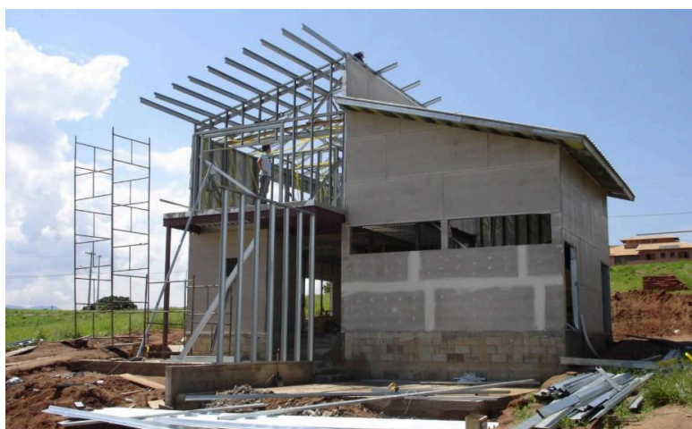
Figura 27: Exemplo de construção em Light Steel Framing
