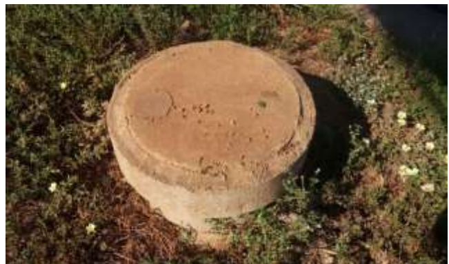
Figura 8. Rede de esgoto.
