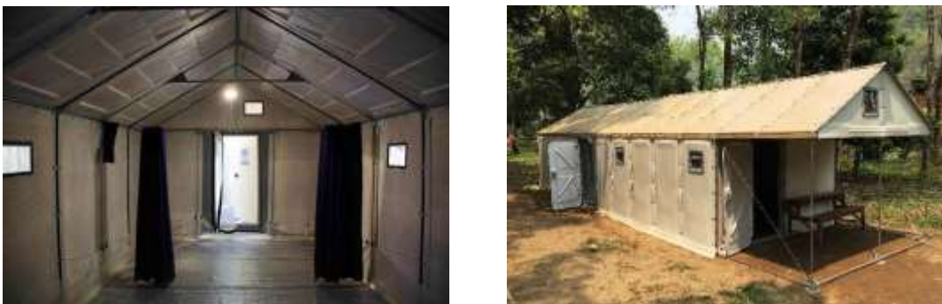
Figura 3. Abrigo com layout flexível. O seu Interior com pouca iluminação e ventilação
