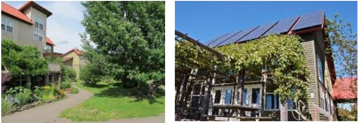
Figura 5 - Relação harmônica do homem com a natureza. Painéis solares e proteção vegetal nas aberturas para diminuir incidência solar.
