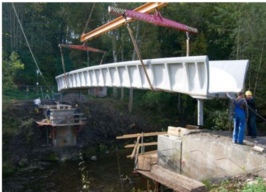
Figura 6 – Passarela na cidade de Kempten, Alemanha em concreto
