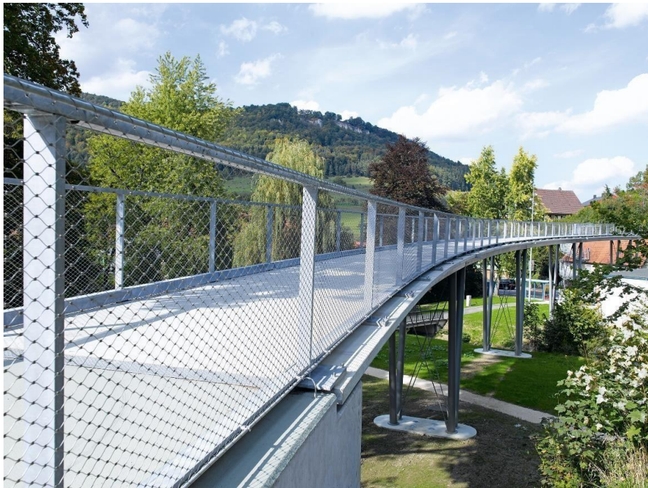
Figura 7 – Ponte em concreto têxtil na cidade de Albstadt, Alemanha
