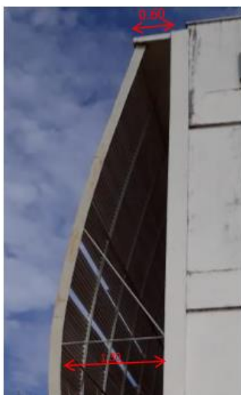
Figura 11 – Espaçamento do brise até a parede. Fonte: Autora, 2018.
