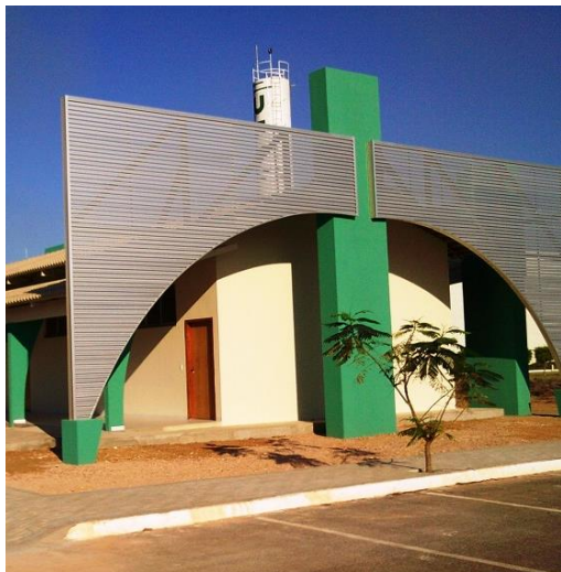
Figura 16 – Brise das salas de aulas do Bloco I da Universidade Federal do Tocantins em Palmas-TO. Fonte: Autora, 2018.
