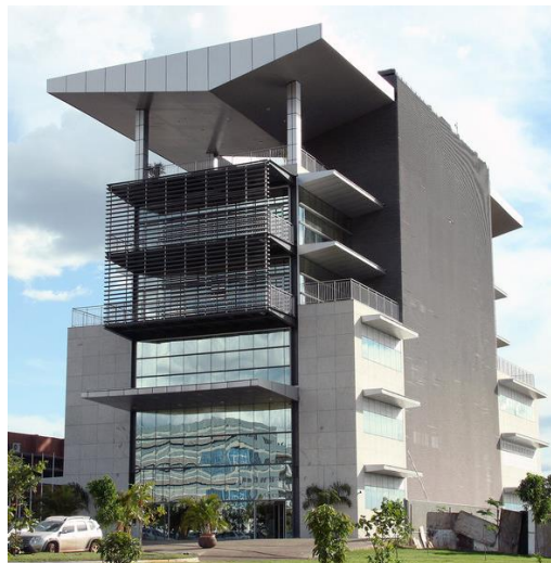
Figura 17 – Exemplos de elementos de proteção solar externo do prédio da Justiça Federal em Palmas-TO. Fonte: Imagens do Google, 2013.
