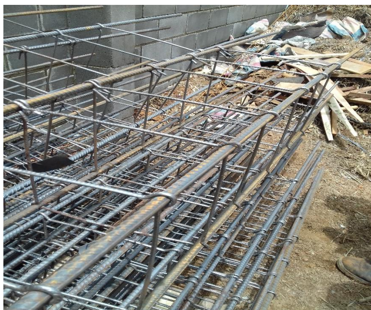
Figura 11 Armações das Fundações
