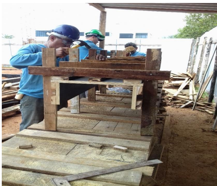
Figura 12 Montagem das Formas
