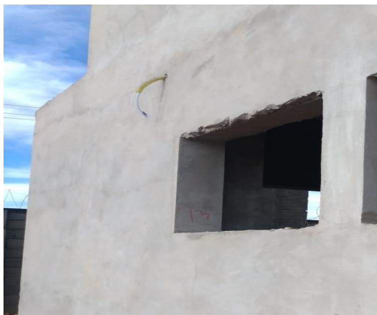
Figura 14 Execução dos Rebocos
