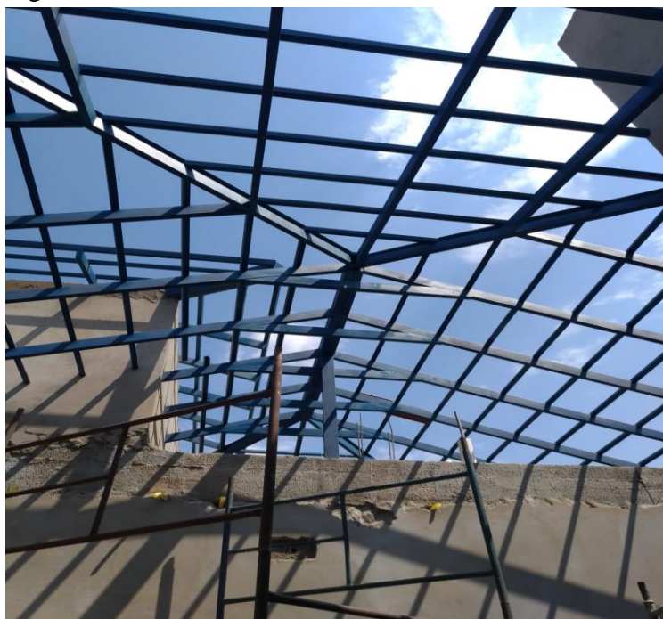
Figura 15 Estrutura Metálica Cobertura
