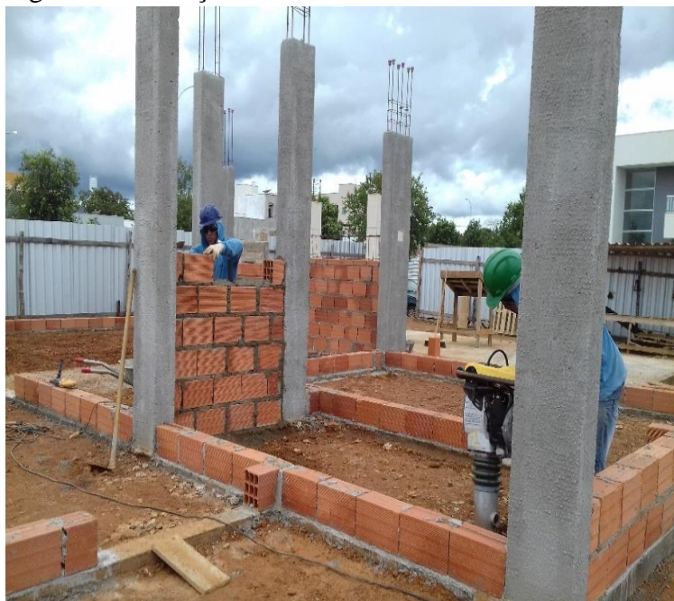
Figura 13 Execução das alvenarias.
