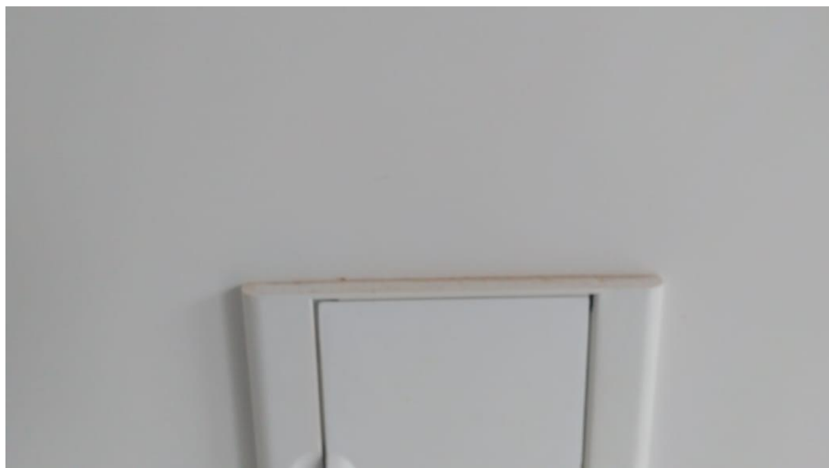
Imagem 26 – Paredes após pintura.
