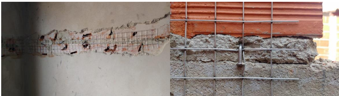
Imagem 19 – Aplicação da tela eletrosoldada.
