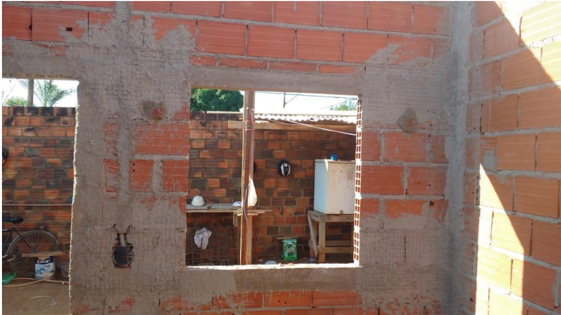
Imagem 21 – Aplicação da tela eletrosoldada em janelas.
