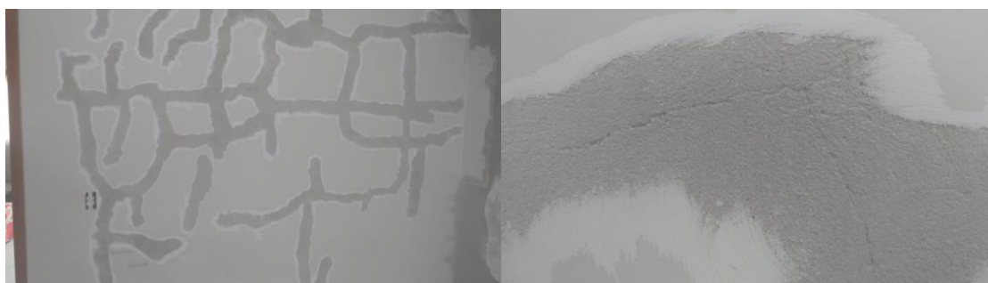
Imagem 30 – Desbastamento de fissuras mapeadas.
