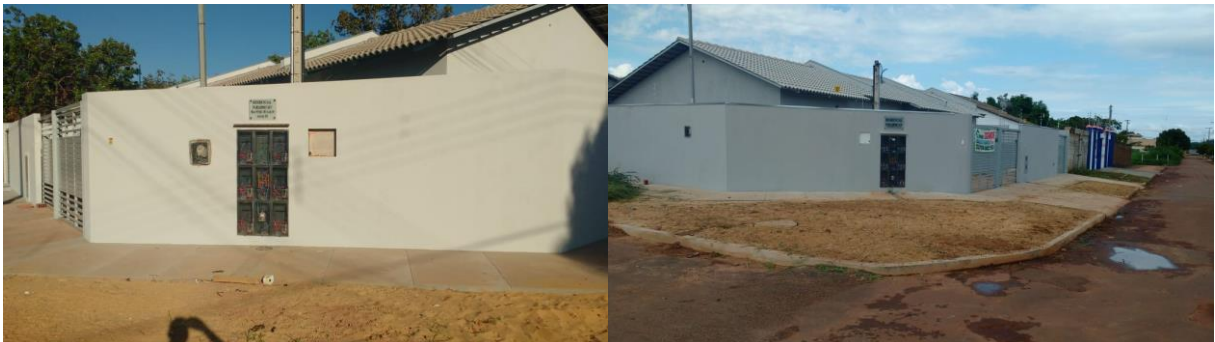
Imagem 15 – Fachada dos dois Residenciais Analisados
