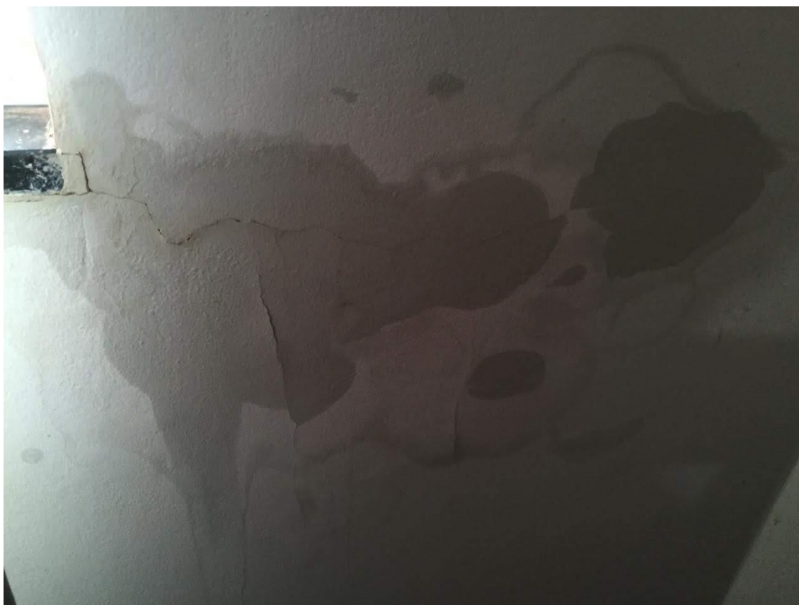
Imagem 20 – Fissuração no canto de janela.
