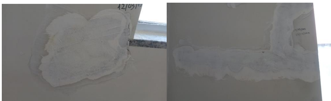
Imagem 37 – Aplicação método de bandagem em fissuras térmicas
