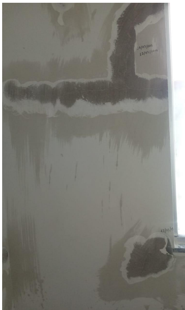
Imagem 36 – Desbastamento de fissuras térmicas
