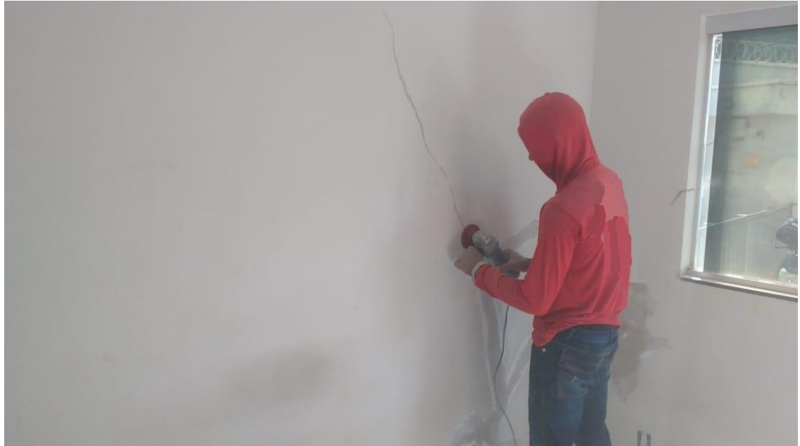
Imagem 18 – Uso de esmerilhadora para desbastamento de fissura.
