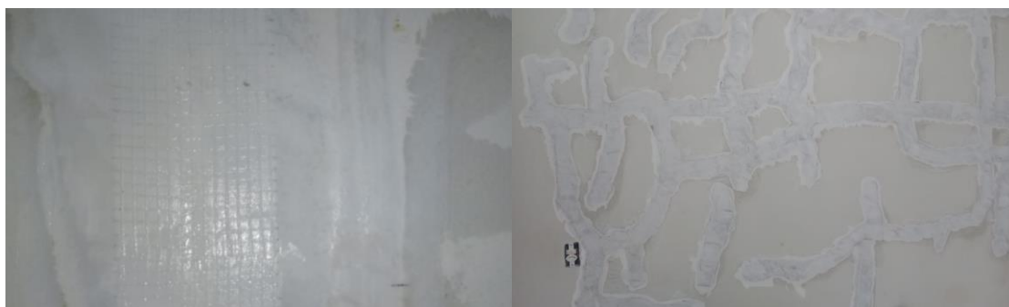
Imagem 31 – Aplicação método de bandagem em fissuras mapeadas.
