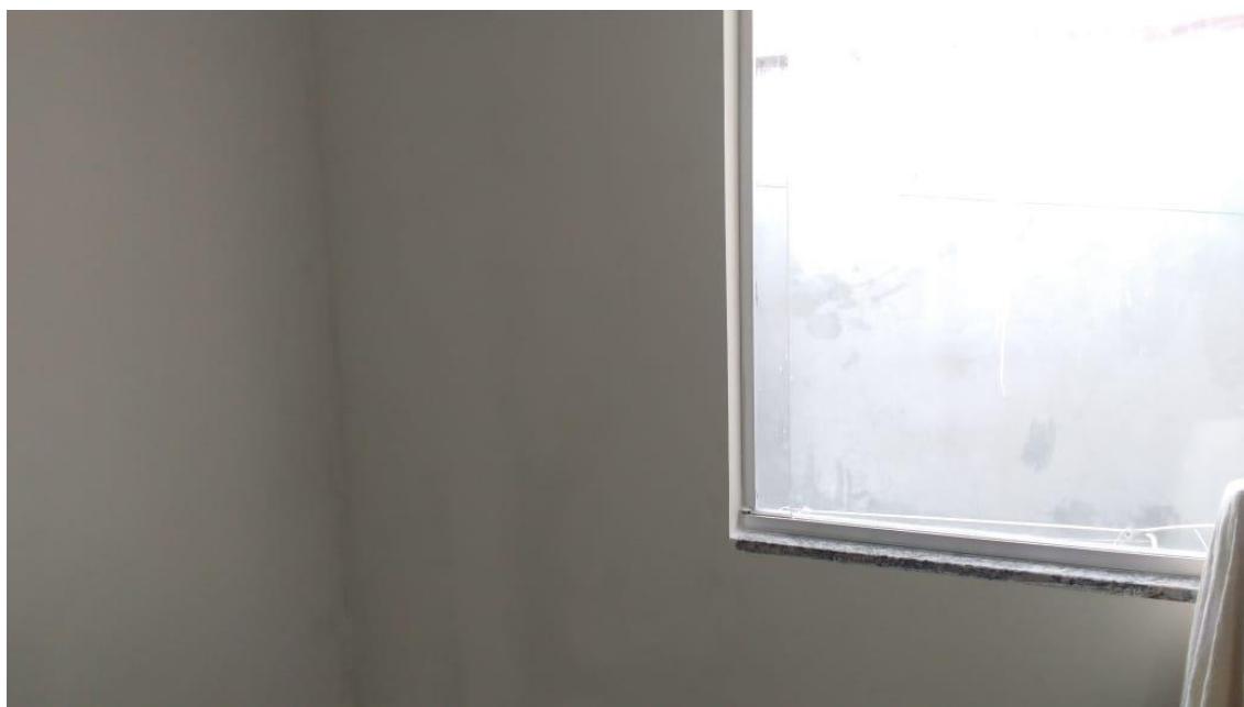
Imagem 38 – Vistoria após aplicação de bandagem em fissuras térmicas
