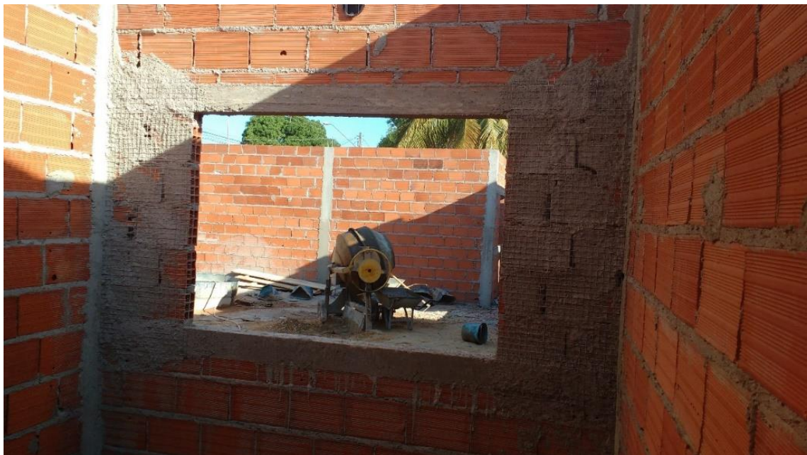
Imagem 22 – Aplicação da tela eletrosoldada em janelas.
