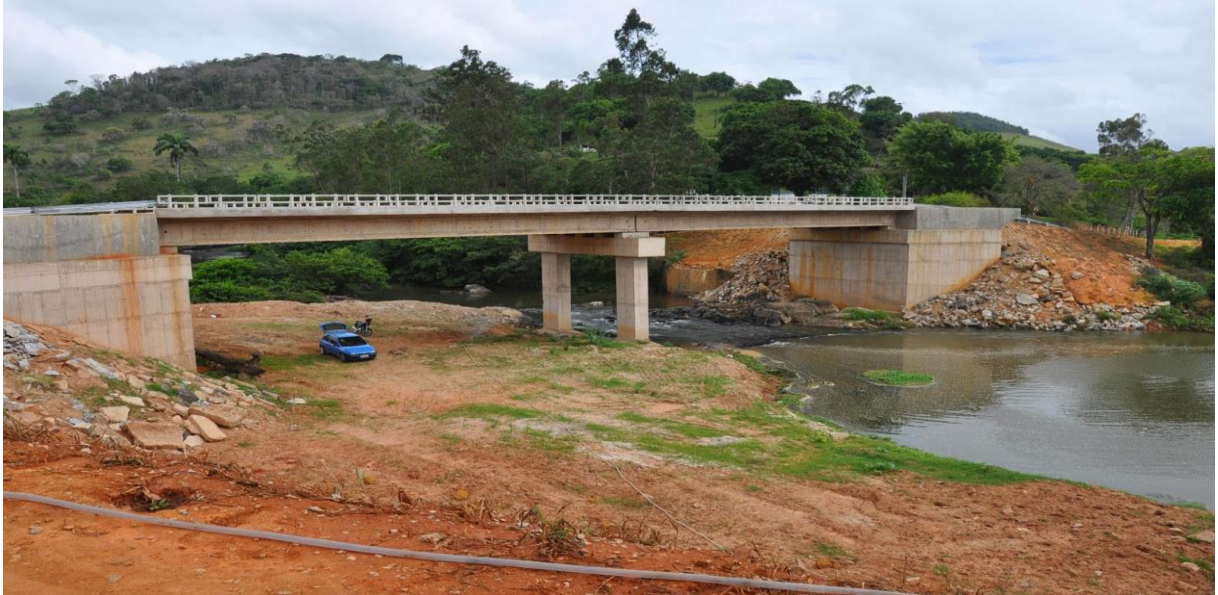
Figura 2 - Ponte em laje
