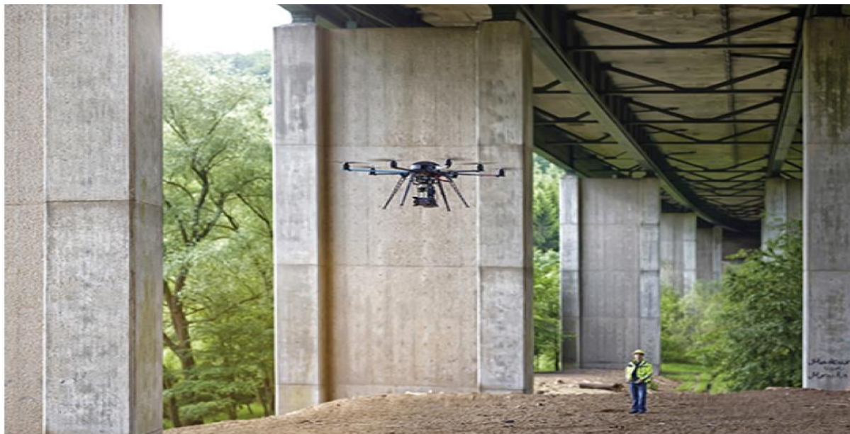
Figura 15 - Inspeção em uma ponte com o uso de drone
