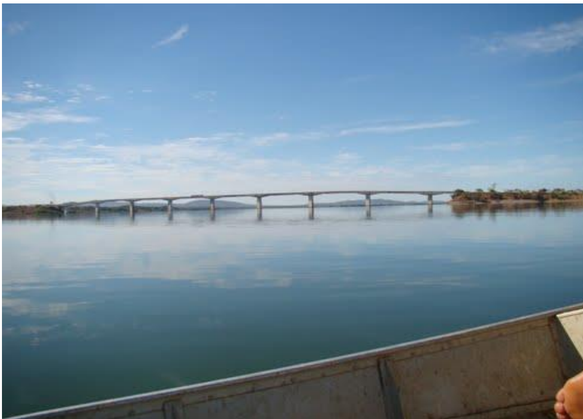
Figura 17 - Vista lateral da Ponte de Porto Nacional
