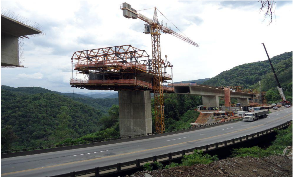
Figura 6 – Construção In loco
