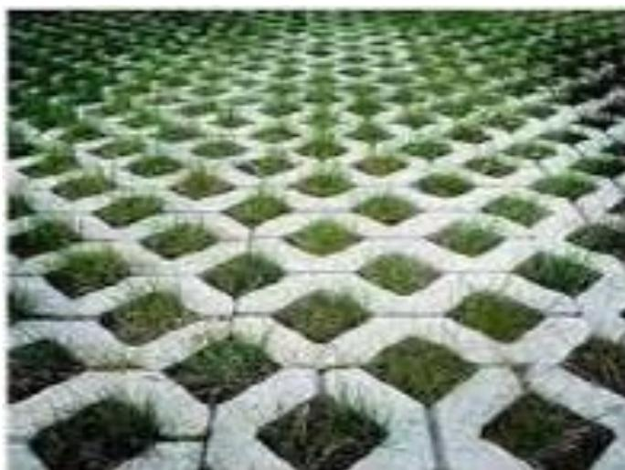
**Figura 7** - Bloco Vazado de Concreto (KUMAR, 2014, p. 25).
