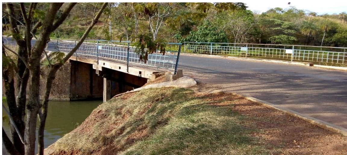
Figura 10- Atual estrutura da ponte
