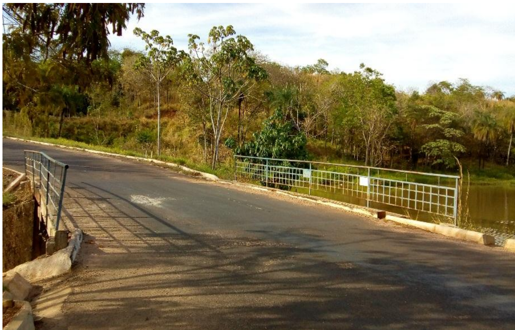
Figura 11- Atual estrutura da ponte
