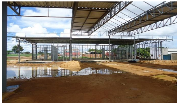
Figura 6. Montagem estrutural do posto na Aurenly I
