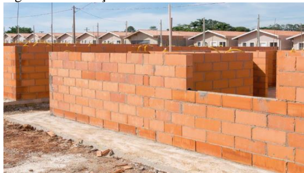
Figura 2. Edificação em alvenaria convencional
