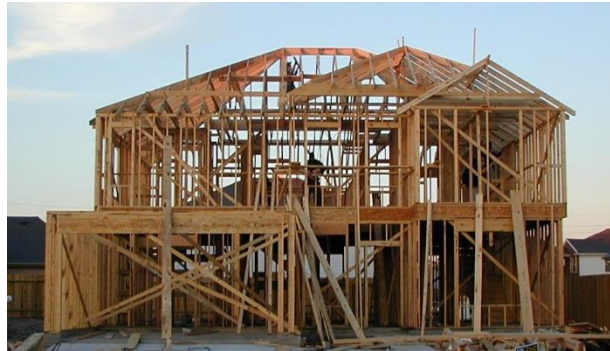
Figura 3. Sistema wood frame
