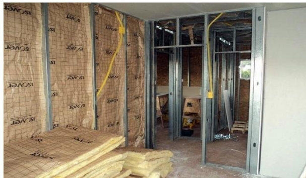
Figura 15. mantas isolantes no interior das paredes
