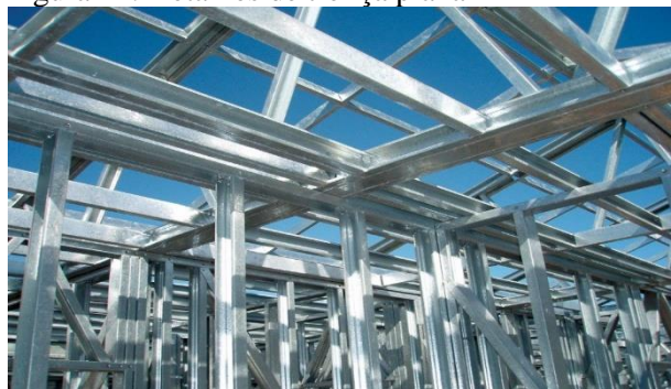
Figura 14. Detalhes de treliça plana
