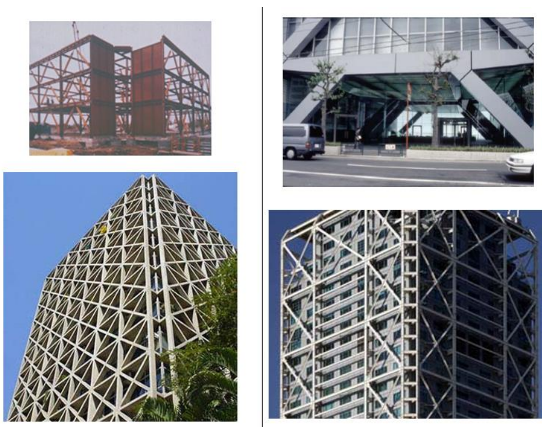
Figura 6 - Contraventamento planos conjuntos com resultante espacial.
