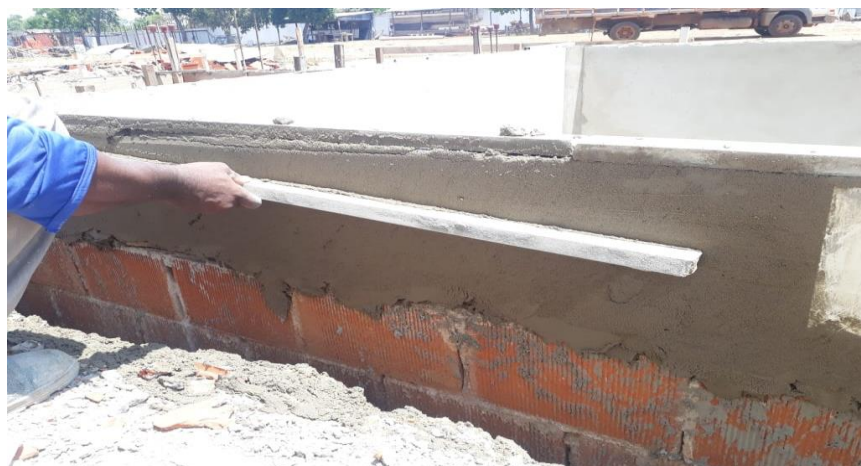
Figura 1- Argamassa de Assentamento em Bloco Cerâmico Estrutural
