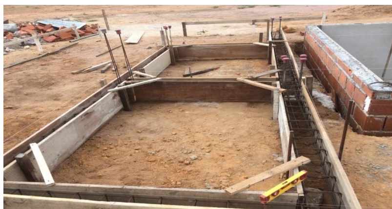
Figura 3 - Posicionamento de Armadura em Viga Baldrame
