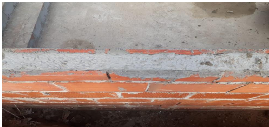
Figura 2 - Grauteamento em Bloco Cerâmico Estrutural
