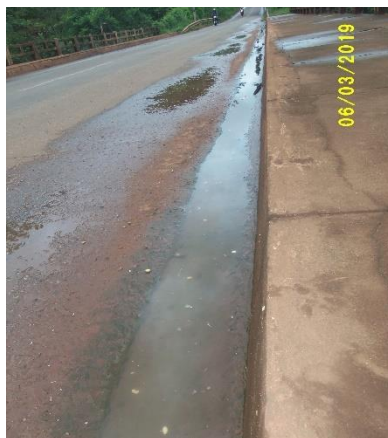
Figura 32: Acúmulo de água nas laterais do tabuleiro
