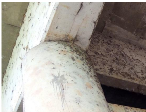
Figura 17: Fissuras na LOG1 no encontro com P2
