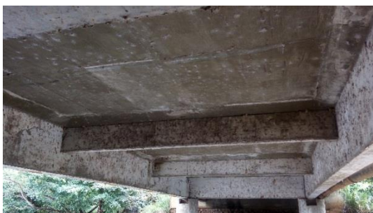
Figura 36: Visão das vigas e longarinas da Ponte da Rua Dom Alano
