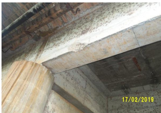
Figura 45: Armadura exposta
