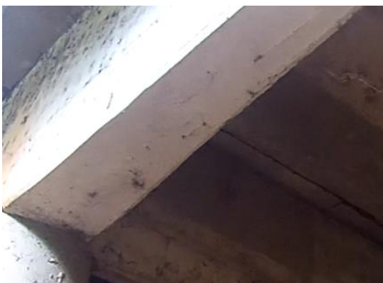
Figura 28: Fissuras na parte de baixo da LOG2
