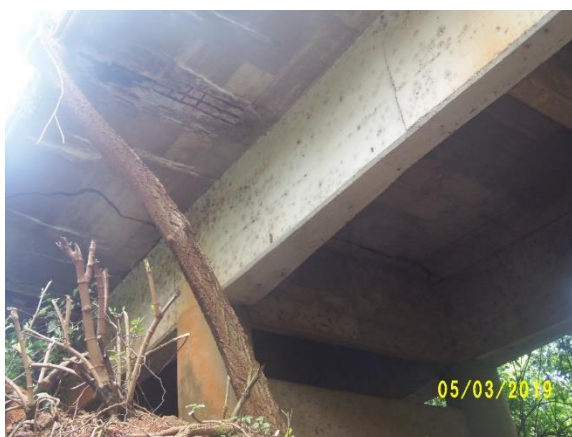
Figura 25: Armadura exposta e eflorescências na laje (próximo ao P6)
