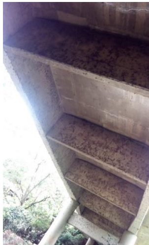
Figura 14: Eflorescências na laje
