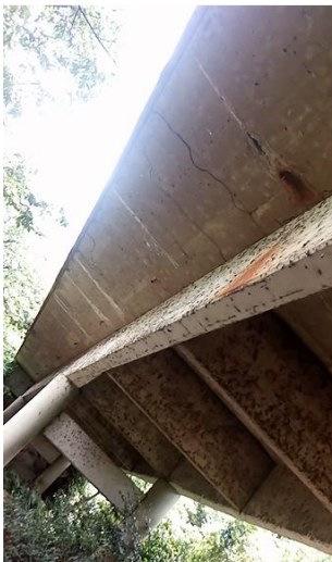
Figura 16: Fissuras e eflorescências
