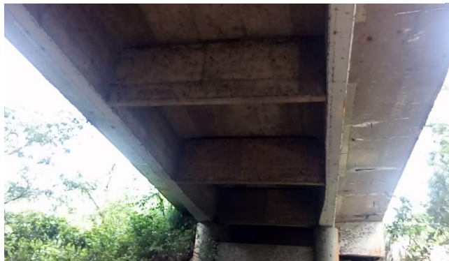
Figura 26: Fissuras com eflorescências na laje
