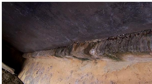
Figura 51: Bolor em uma viga da Ponte da Av. Monte do Carmo
