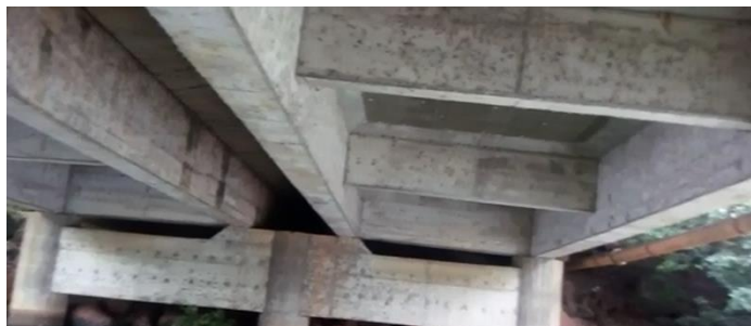
Figura 47: Vista das vigas transversinas
