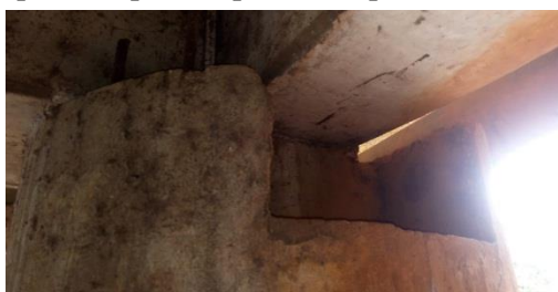
Figura 40: Armadura exposta na parte superior dos pilares da Ponte da Rua Dom Alano
