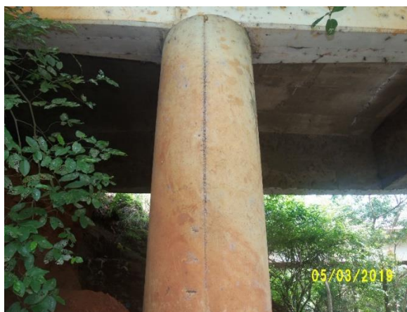
Figura 19: Ninchos de concretagem P6
