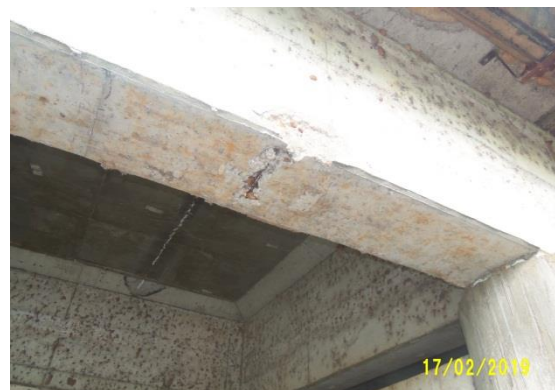
Figura 46: Armadura exposta e segregação do concreto
