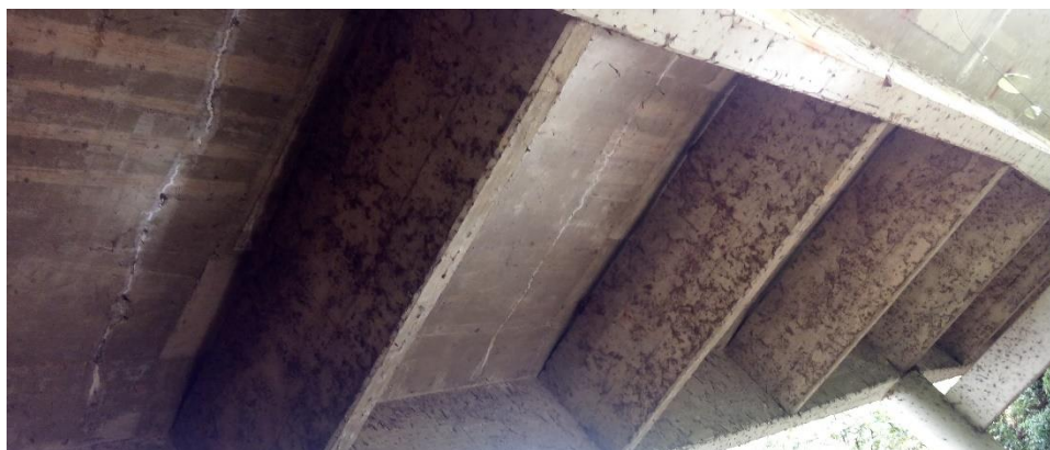
Figura 18: Manchas de umidade nas transversinas
