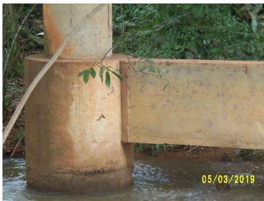
Figura 29: Erosão, manchas de umidade e ninchos de concretagem no P3
