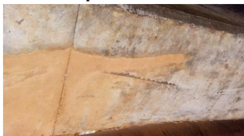
Figura 37: Armadura exposta na Ponte da Rua Dom Alano
