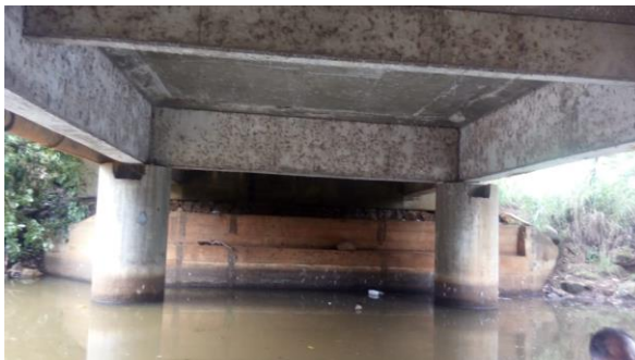
Figura 38: Erosão nos pilares da Ponte da Rua Dom Alano
