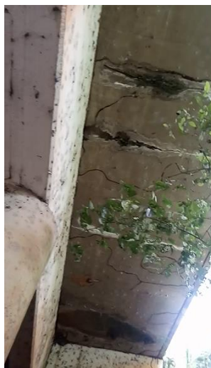
Figura 15: Manchas de Umidade na laje
