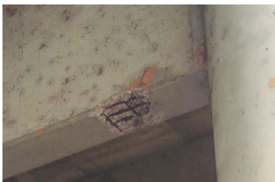
Figura 30: Armadura exposta na VTR2
