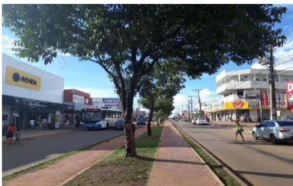
Figura 20- Via coletora e ciclovia da Avenida Tocantins.
