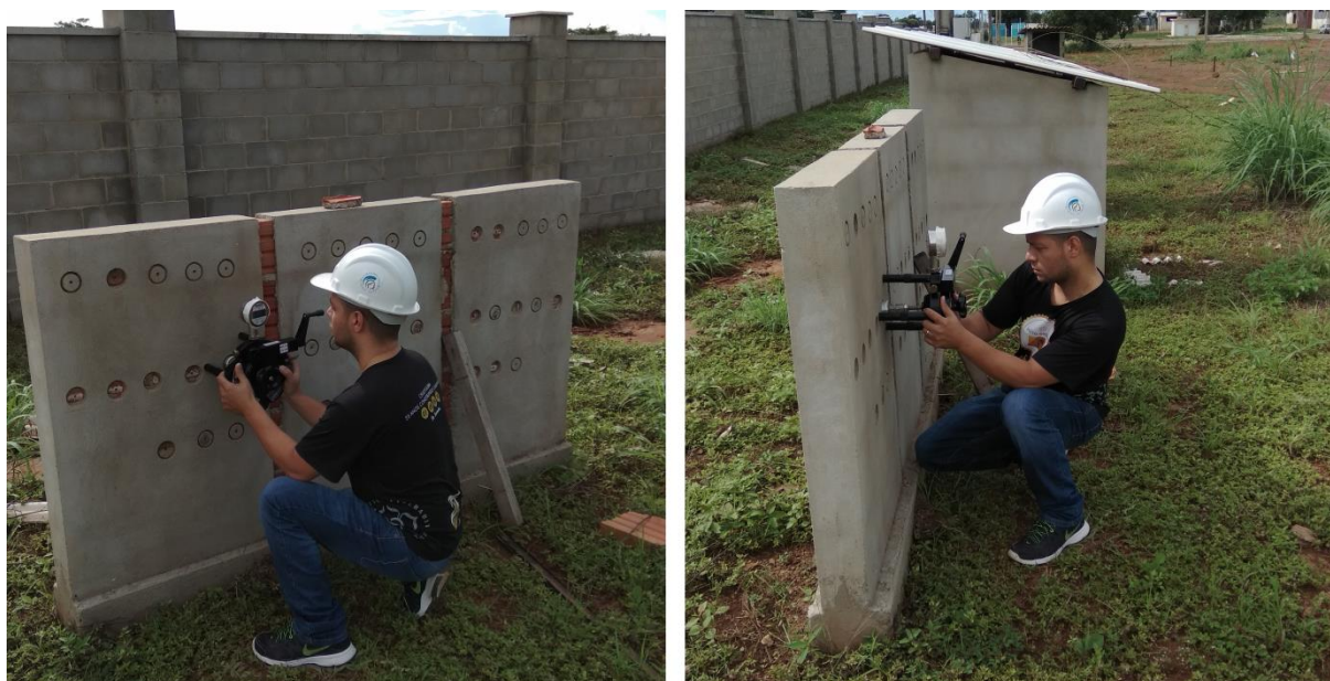
Figura 15 – Ensaio de arrancamento
