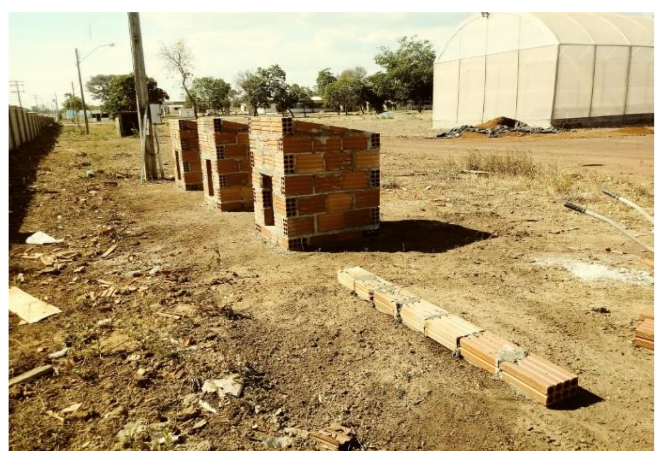
Figura 14 - Construção do protótipo
