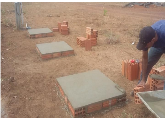
Figura 13 - Contrapiso do protótipo
