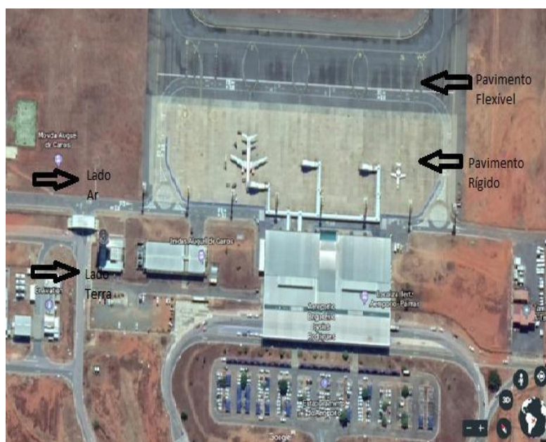
Figura 9 - Pátio de aeronaves e pista de taxiamento
