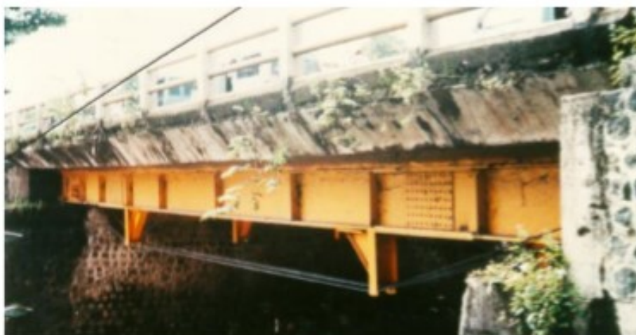
Figura 17 - Desviadores para posicionamento abaixo da viga metálica.
