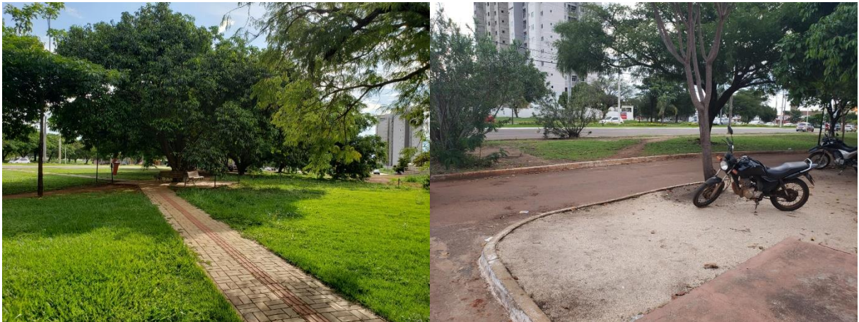
Figura 8- Calçadas de prédios, localizadas nos trechos avaliados.
