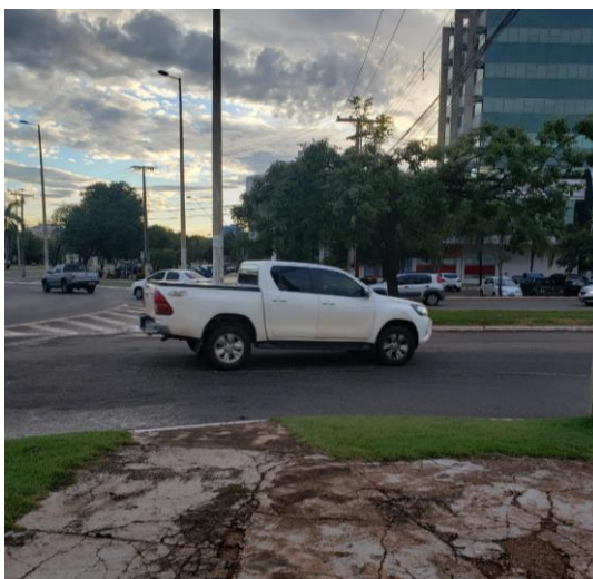
Figura 12 – Trecho 11, encontro da avenida JK e rotatória na NS 4.
