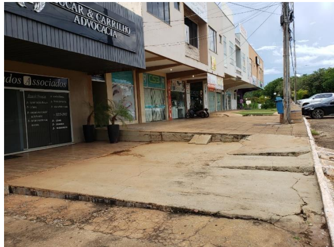
Figura 7- Calçadas de prédios, localizada nos trechos avaliados.
