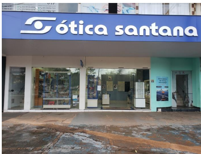
Figura 15 – Calçada de prédio comercial.
