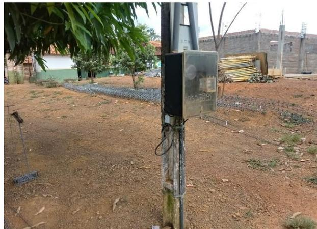
Imagem 6 – Quadro de medição de energia sem proteção contra impactos
