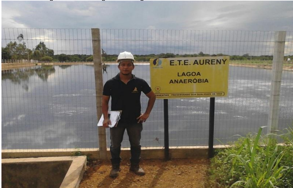
Figura 13 - Vista geral da Lagoa Anaeróbia da ETE AURENY
