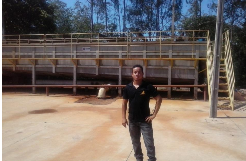
Figura 30 - Reator anaeróbio de fluxo ascendente - UASB
