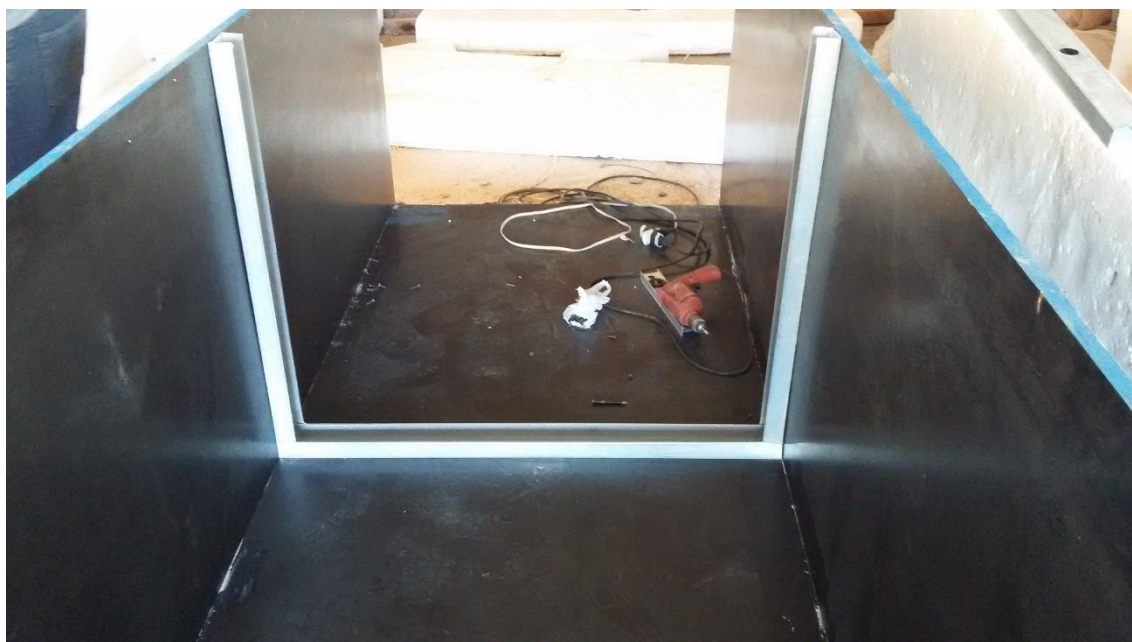
Montagem da estrutura do drywall
