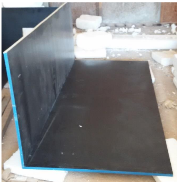
Figura 9 - Montagem das paredes
