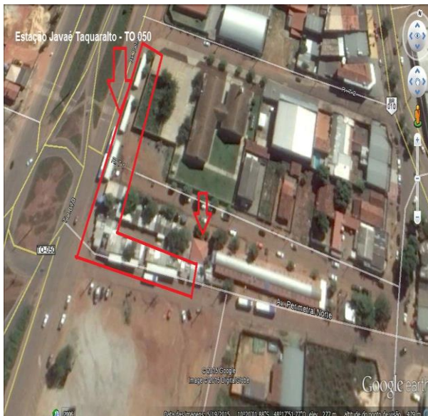
Figura 59 - Vista da Estação Javaé em Taquaralto, Palmas-TO
