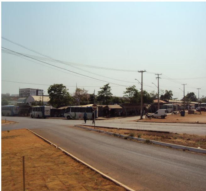
Figura 66 - Vista da Rodovia TO 050 com travessia de pedestre fora da faixa
