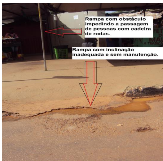
Figura 77 - Calçadas e rampas com estacas de ambulantes atrapalhando a passagem de pedestres
