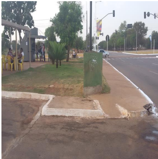
Figura 44 – Vista da calçada / Calçada e rampa com o guichê de vendas
