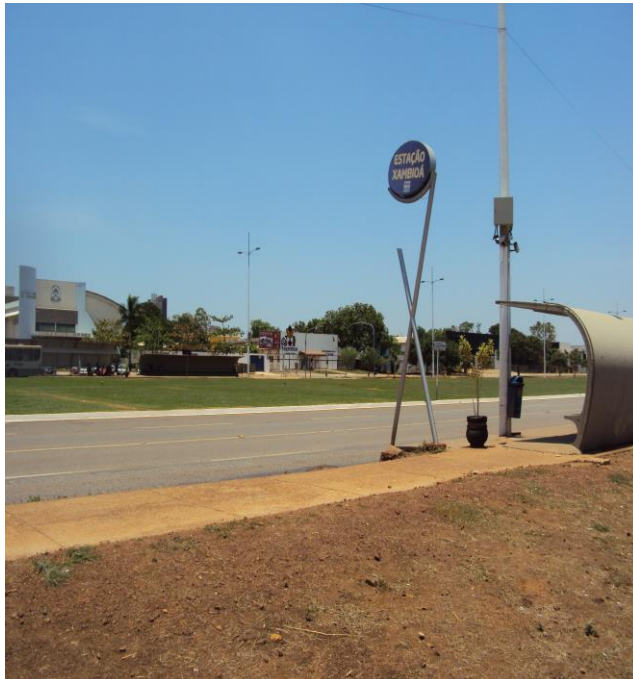
Figura 37 - Vista da Estação Xambioá, Palmas-TO
