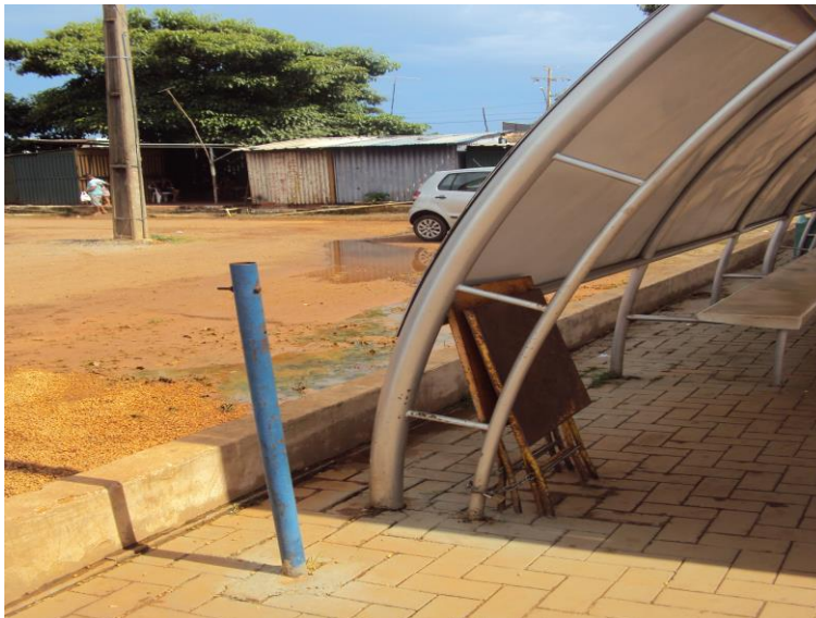
Figura 62 - Vista do esgoto a céu aberto
