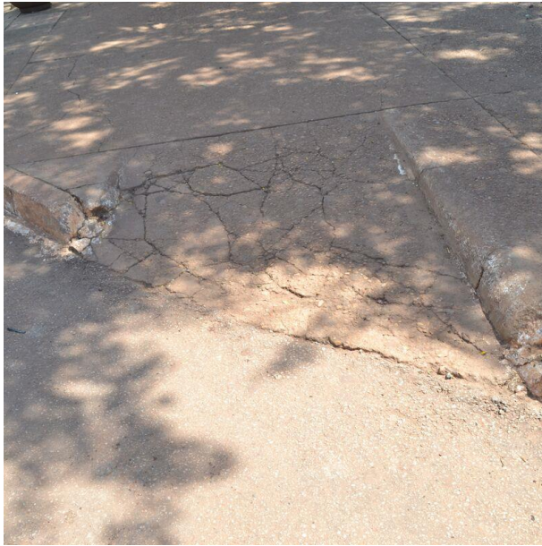
Figura 21 - Rampas de acesso da Estação Apinajé
