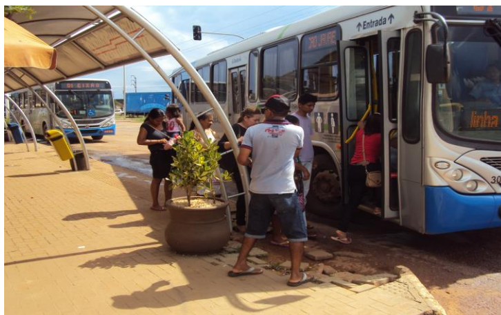
Figura 80 - Sinalização tátil sem manutenção no ponto de ônibus
