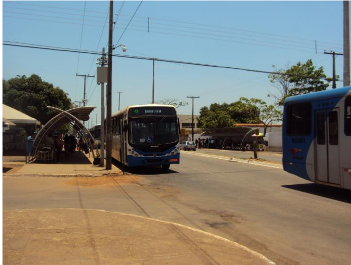
Figura 50 – Vista da Estação Xerente, Palmas-TO
