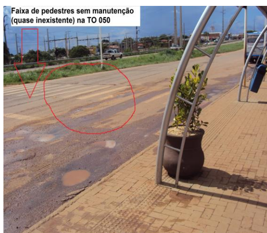
Figura 69 - Faixa de pedestre na travessia da TO 050 sentido Bairro Santa Barbara na Estação Javaé
