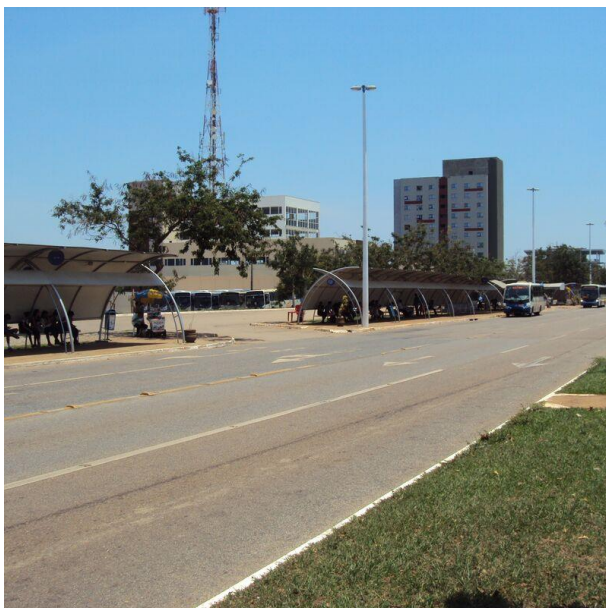
Figura 24 – Vista sul/norte da Estação Apinajé, Palmas-TO
