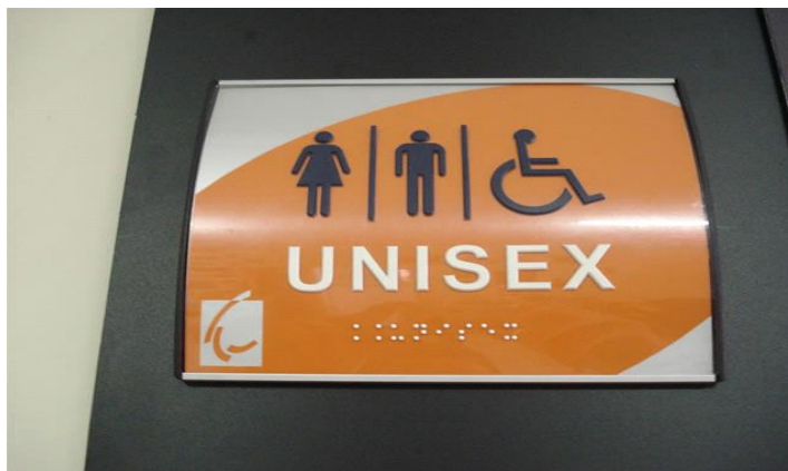
Figura 10 - Sinalização tátil vertical - Placas com alto-relevo e braile
