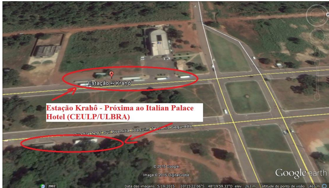
Figura 42 – Vista aérea da Estação Krahô, Palmas-TO
