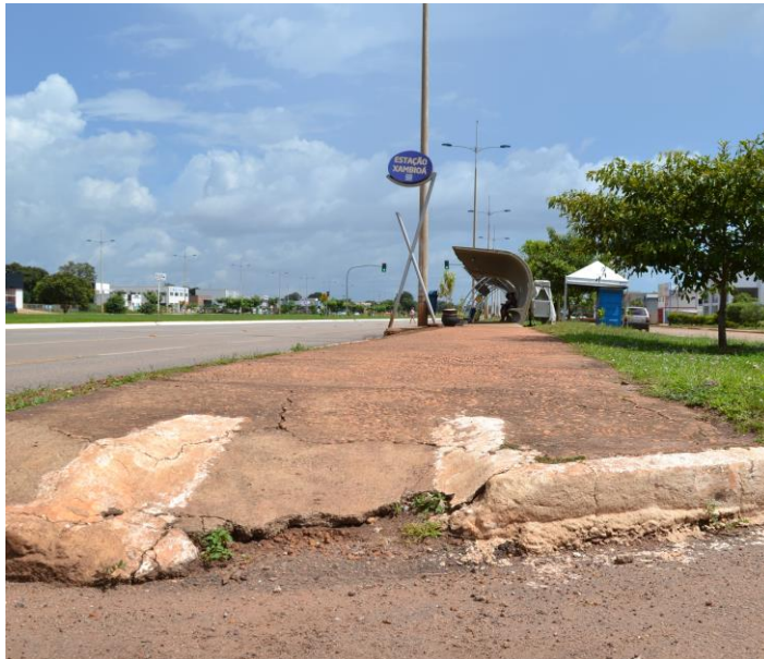
Figura 38 – Rampas na Estação Xambioá.
