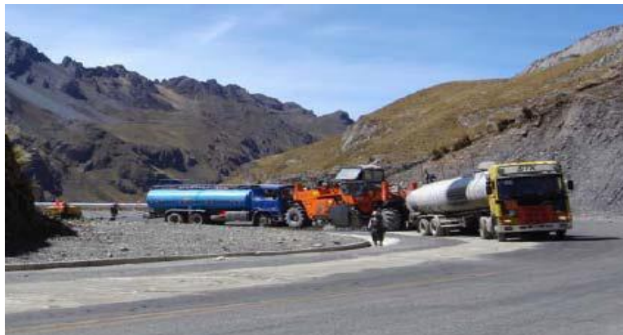
Figura 14: Reciclagem “ in situ ” a frio com espuma de betume
