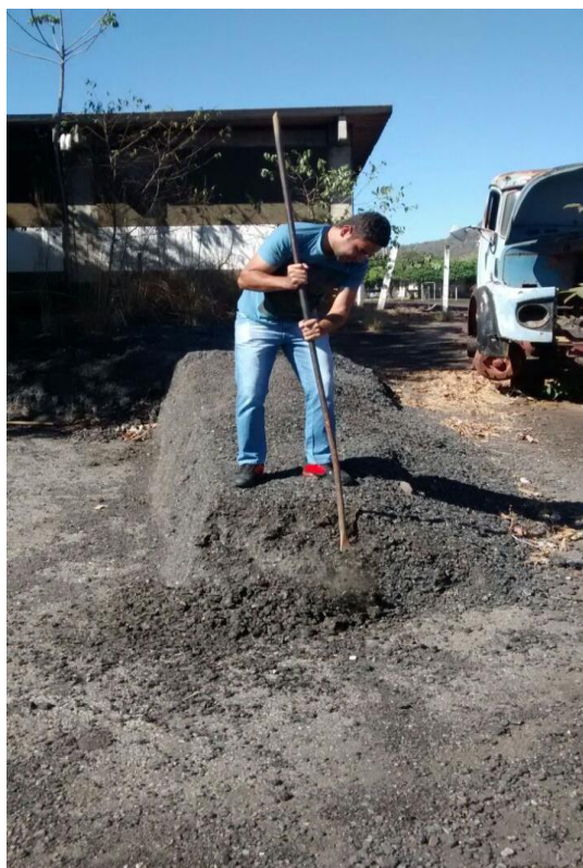
Imagem 1: Coleta do material fresado.
