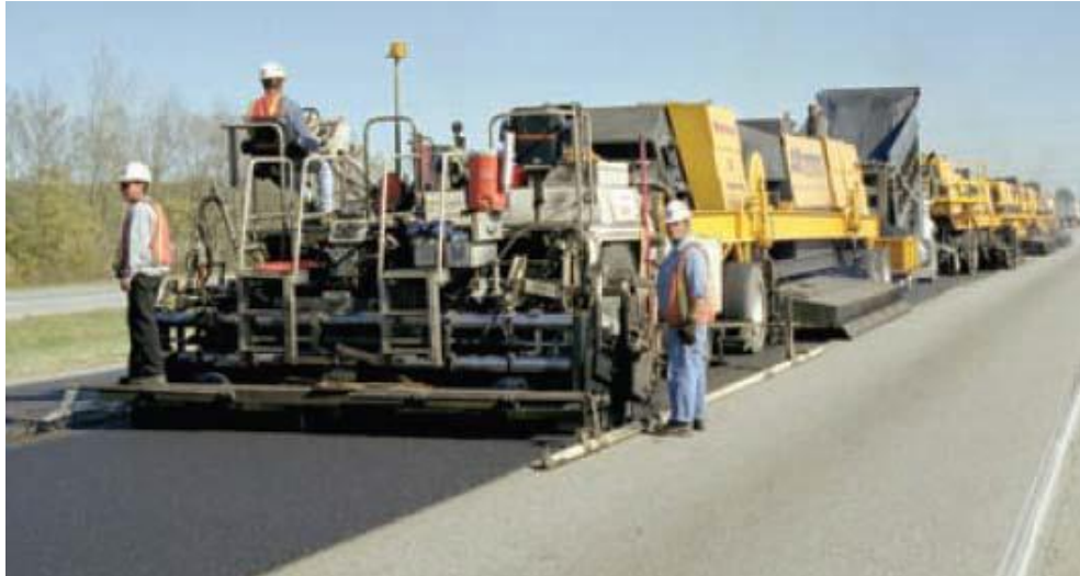
Figura 18: Espalhamento da mistura
