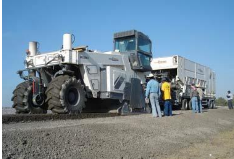
Figura 9: Conjunto recicladora e misturadora
