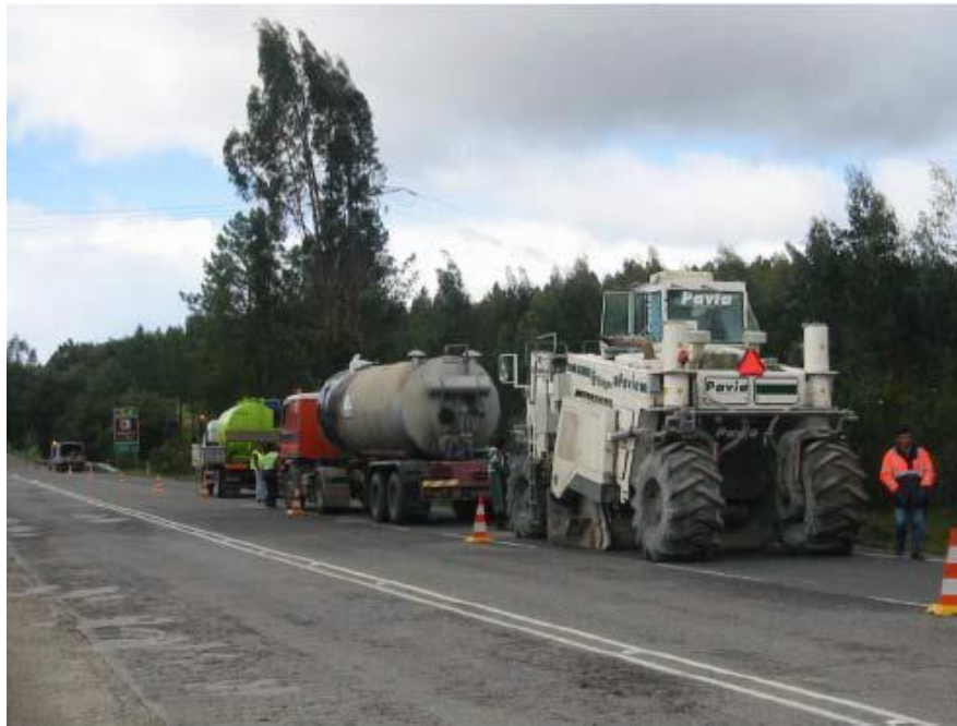
Figura 11: "Comboio" composto pela máquina recicladora, cisternas para água e emulsão betuminosa
