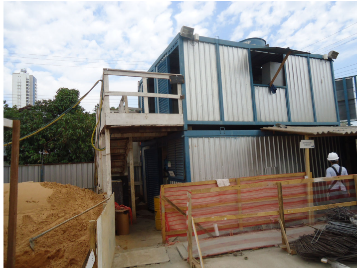
Figura 12 - Instalações em Contêineres.
