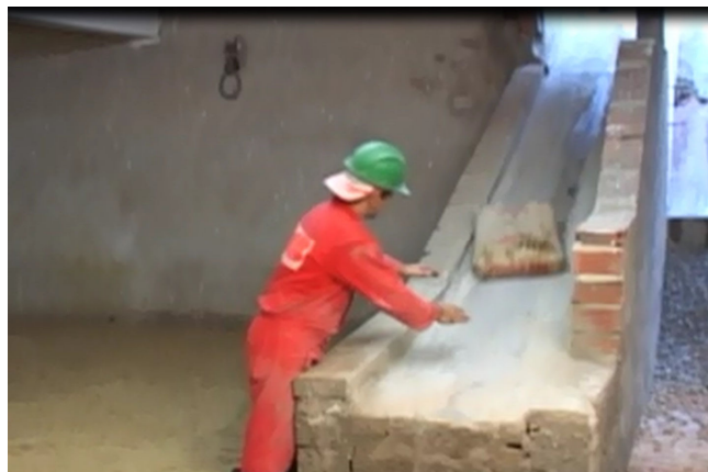
Figura 56 – Distribuição de argamassa e cimento
