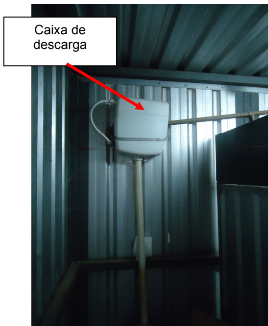
Figura 31 - Caixa de Descarga
