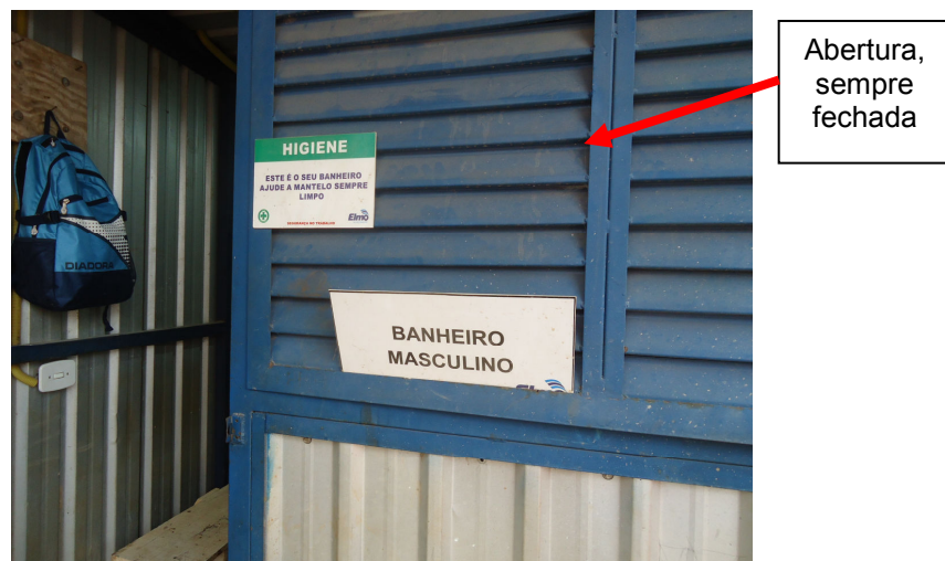
Figura 26 - Janela do banheiro
