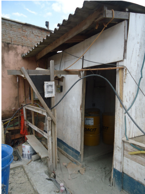
Figura 70 - Acesso ao deposito
