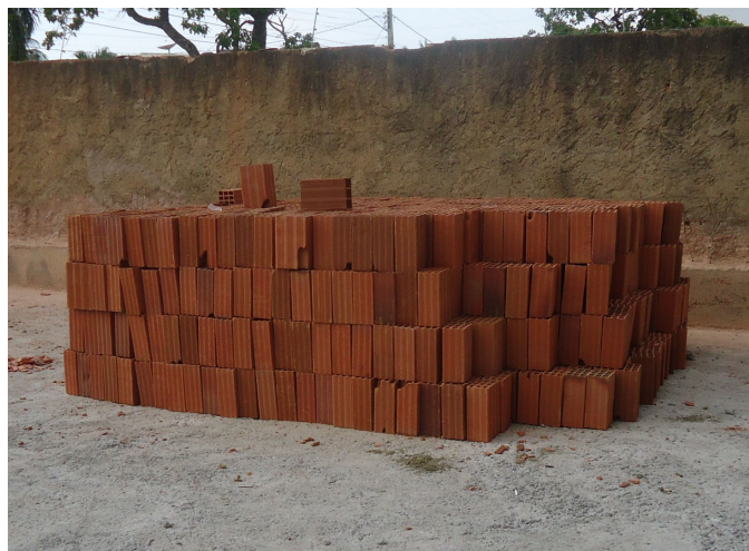
Figura 67 - Empilhamento dos tijolos
